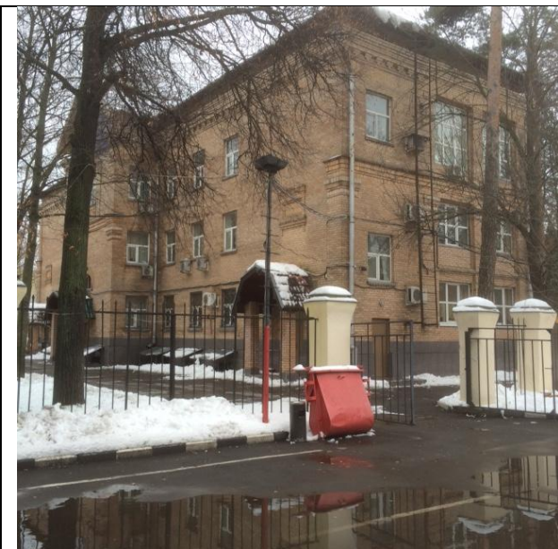
Фотография: Здание, назначение: нежилое, 3-х этажный, (подземных этажей - 1, общая площадь 1603,4 кв.м. адрес (место
