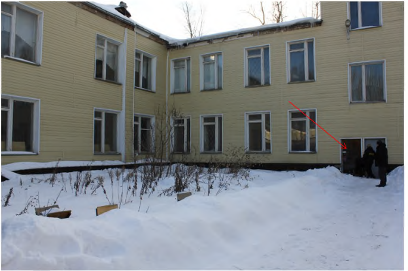
Фото 1.9 Вход в подвал снаружи здания
