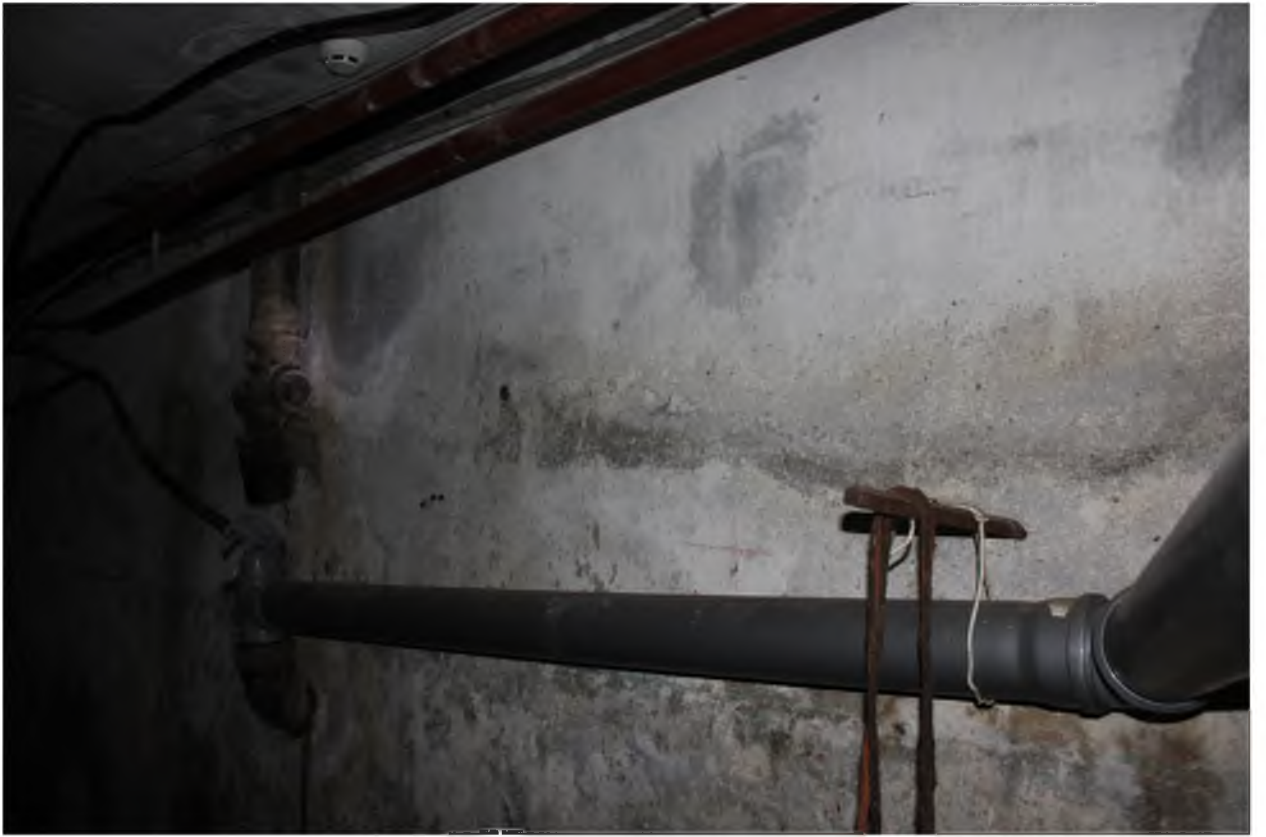
Фото 4.11 Крепление трубы водостока.
