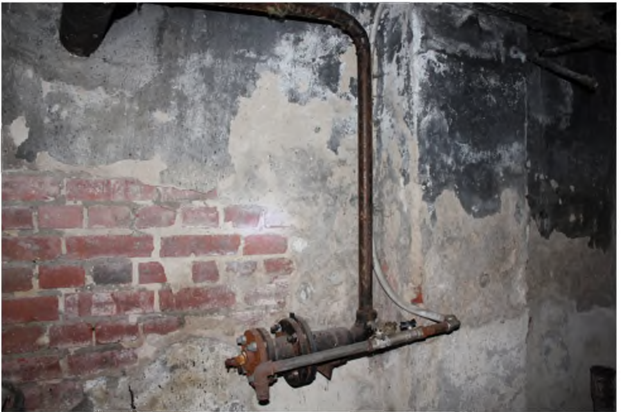
Фото 4.5 Отключение потребителей здания от водоснабжения
