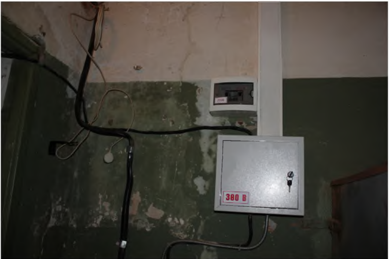
Фото 2.9 Шины подачи электроэнергии потребителям
