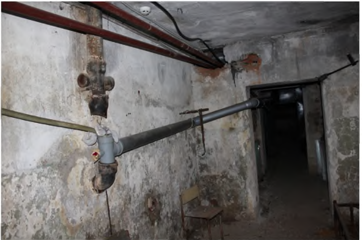
Фото 4.9 Подключение водостока в канализационный стояк
