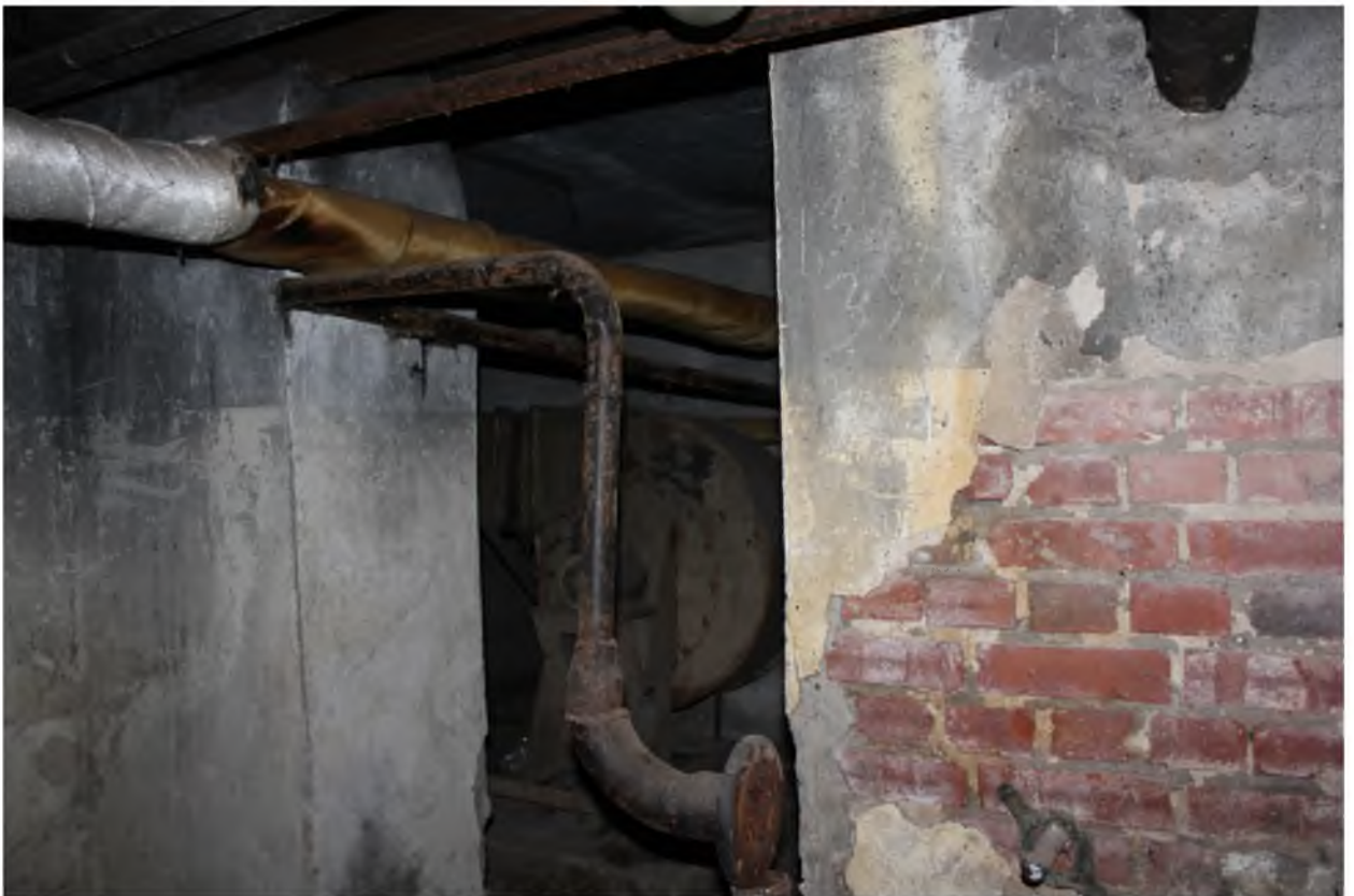
Фото 4.4 Отключение потребителей здания от водоснабжения
