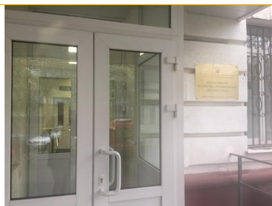
Фото 2. Входная дверь в здание
