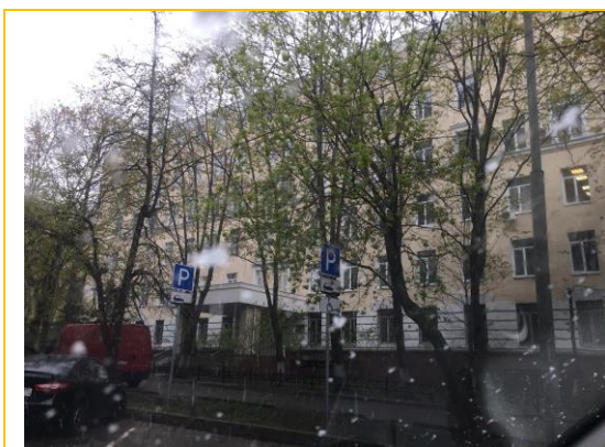
Фото 1. Здание, в котором расположен объект оценки
