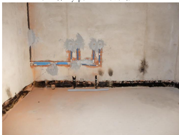
20. Вид внутренних помещений.
