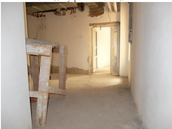
15. Вид внутренних помещений.
