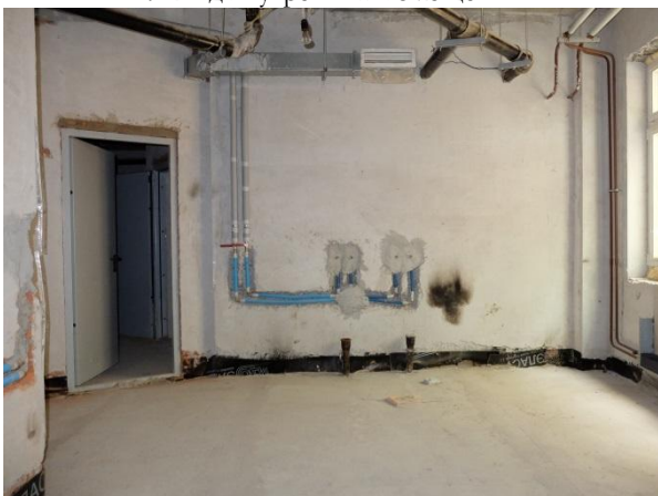
21. Вид внутренних помещений.
