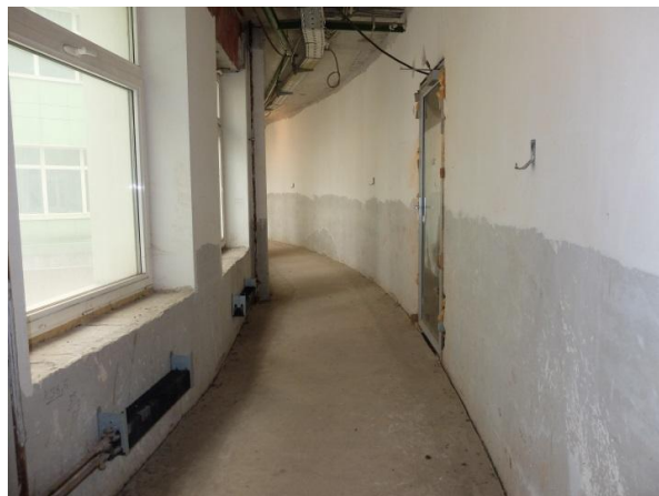
10. Вид внутренних помещений.
