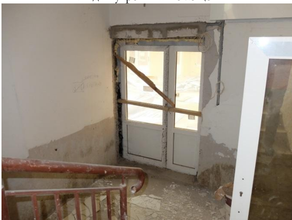
13. Вид внутренних помещений.
