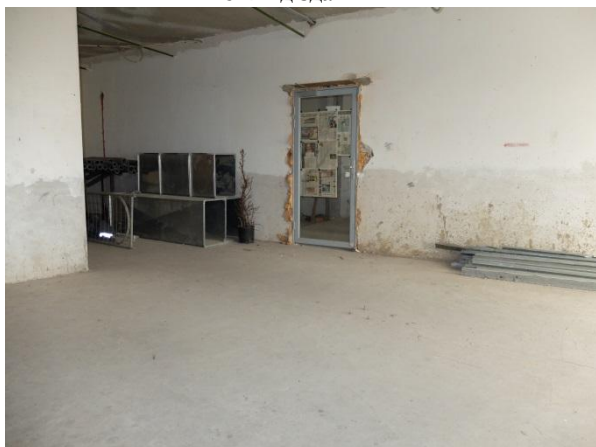
7. Вид внутренних помещений.
