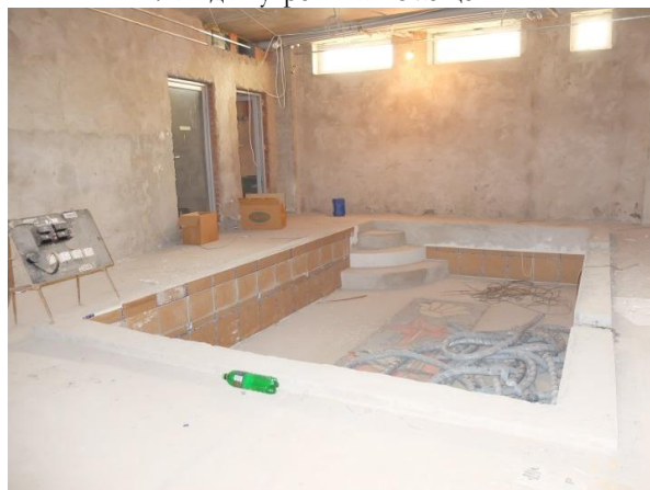
16. Вид внутренних помещений.
