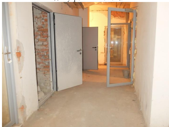
14. Вид внутренних помещений.
