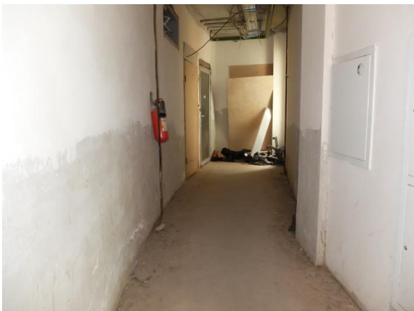
9. Вид внутренних помещений.
