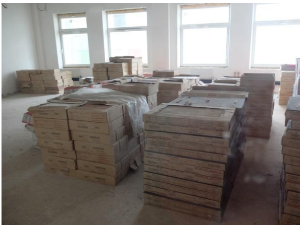
17. Вид внутренних помещений.
