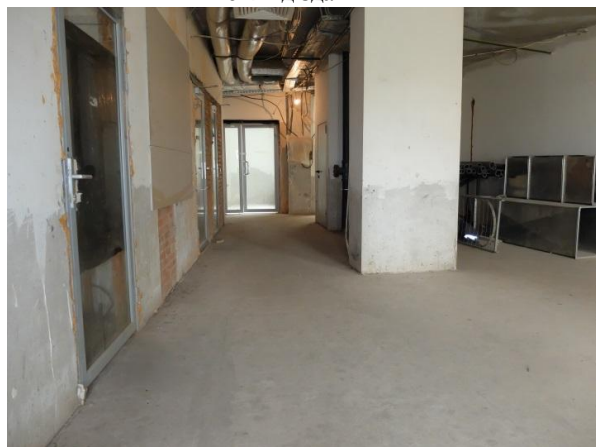
8. Вид внутренних помещений.
