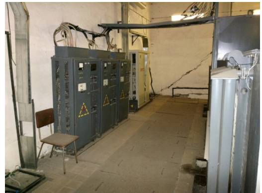
Секция № 1 РТП 18020 камера КСО-2УМЗ, инв.№ ОС000004
