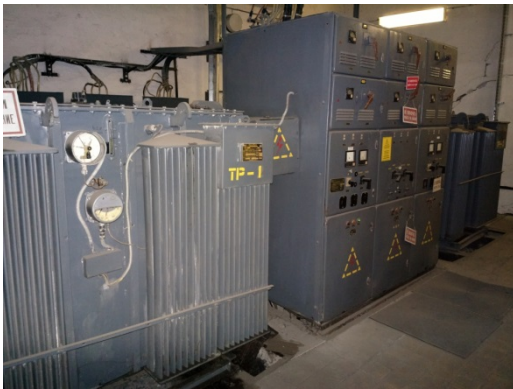
Секция № 1 РТП 18020 камера КСО-2УМЗ, инв.№ ОС000004
