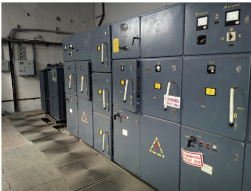
Секция № 2 РТП 18020 камера КСО-2УМЗ, Инв .№ ОС000005
