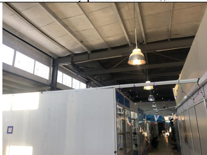
Фото №22 Внутреннее состояние здания
