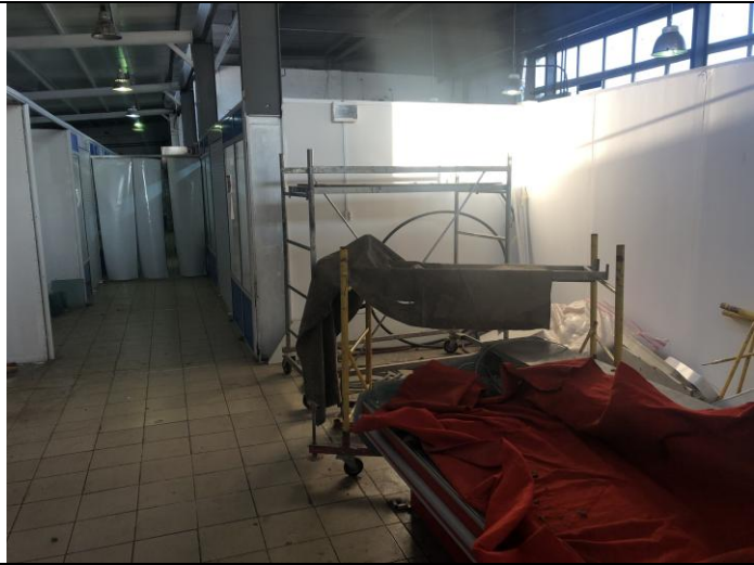
Фото №13 Внутреннее состояние здания
