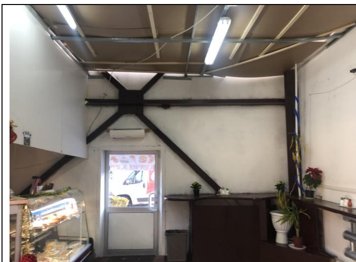
Фото №19 Внутреннее состояние здания
