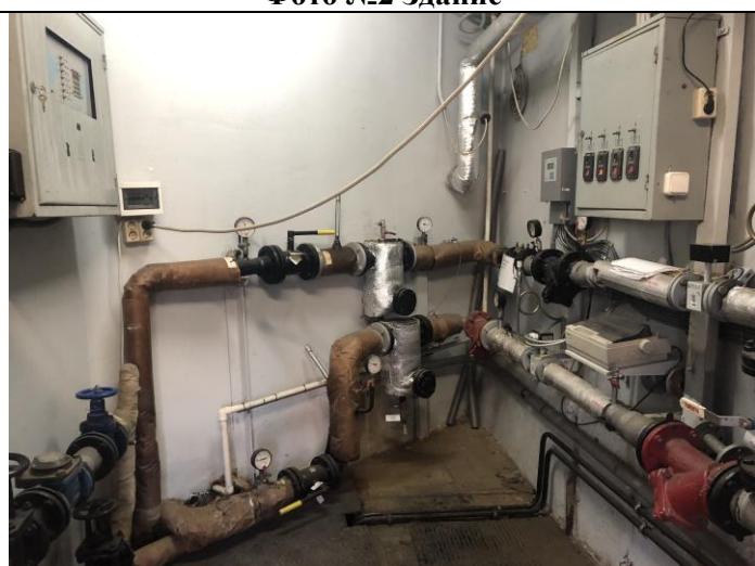
Фото №4 Внутреннее состояние здания
