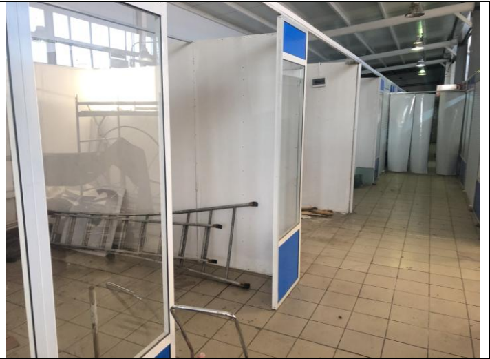
Фото №14 Внутреннее состояние здания
