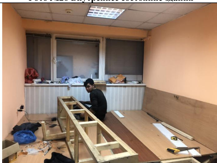
Фото №28 Внутреннее состояние здания
