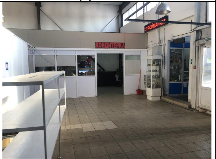
Фото №16 Внутреннее состояние здания
