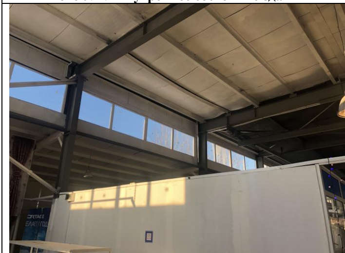
Фото №21 Внутреннее состояние здания
