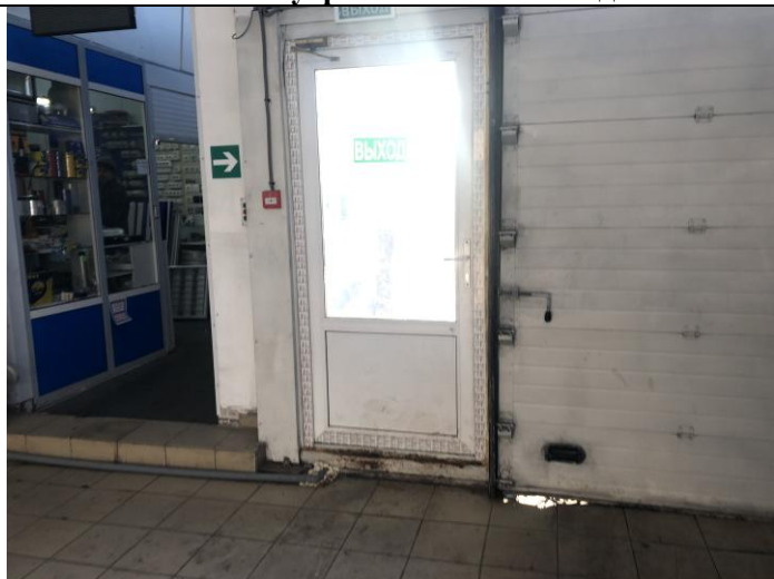
Фото №17 Внутреннее состояние здания
