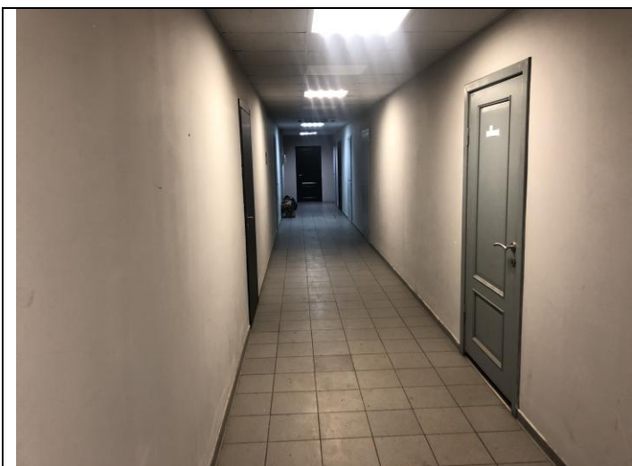
Фото №25 Внутреннее состояние здания
