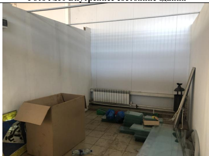
Фото №12 Внутреннее состояние здания
