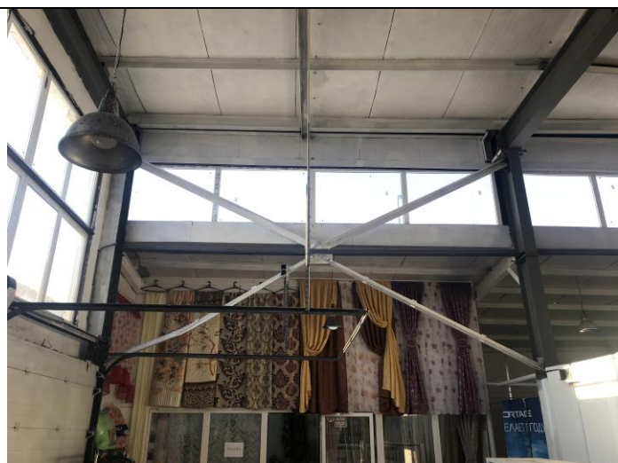
Фото №20 Внутреннее состояние здания
