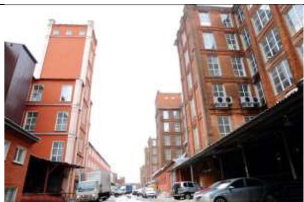
Фото 2 Внешний вид здания
