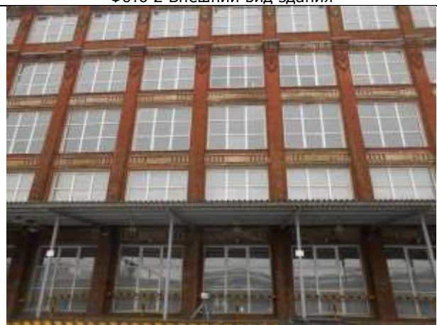
Фото 4 Внешний вид здания
