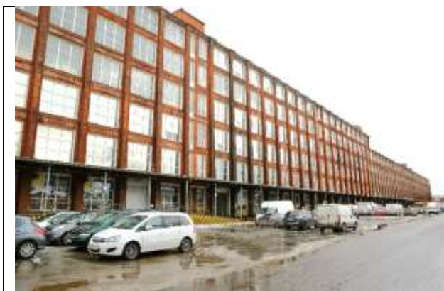
Фото 1 Внешний вид здания
