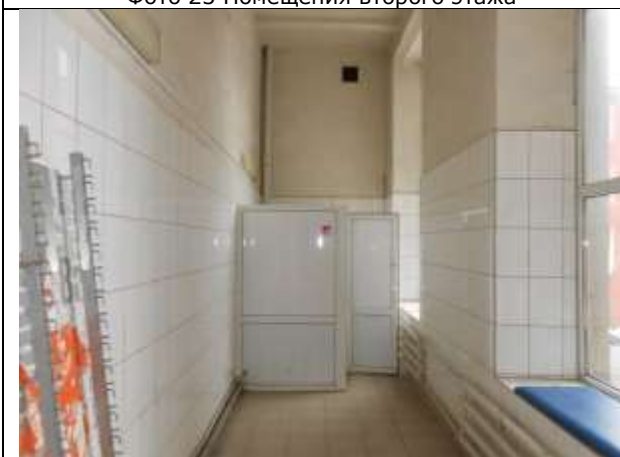
Фото 25 Помещения второго этажа
