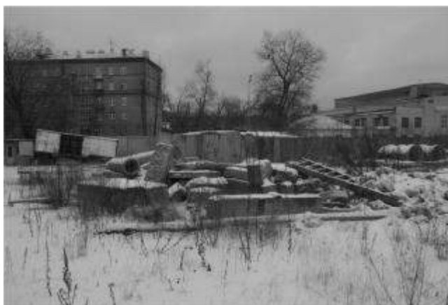
Фото 6.18. Фундамент здания площадью 272,2 кв.м.
