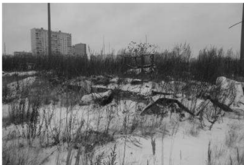
Фото. 6.7. Фундамент нежилого здания общей площадью 132,7 кв.м.
