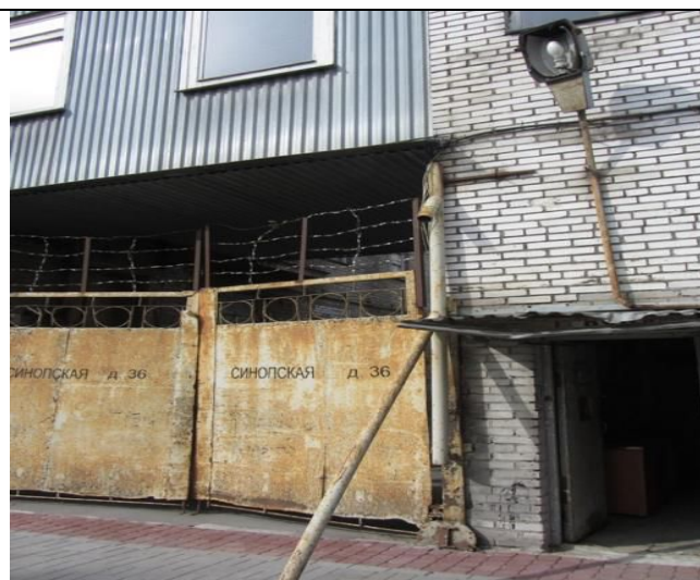
Фото №3 Вход в здание
