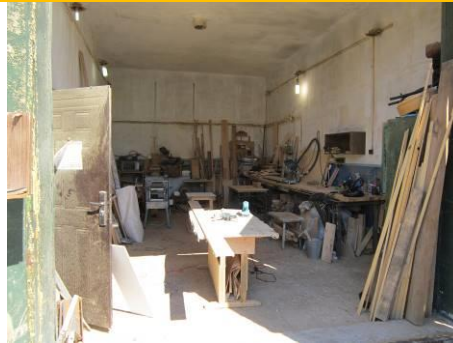
Фото 3. Состояние отделки помещений
