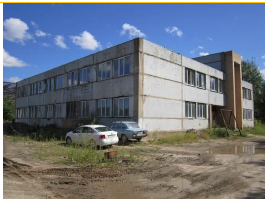
Фото 3. Общий вид здания
