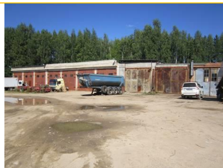
Фото 2. Общий вид здания
