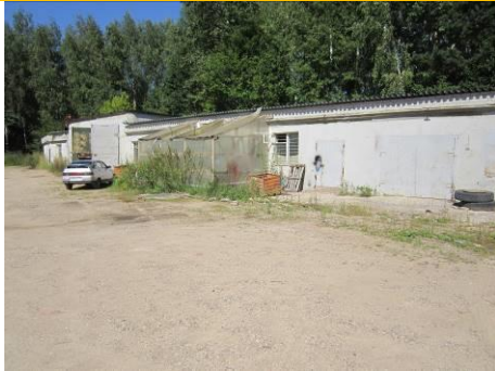
Фото 1. Общий вид здания
