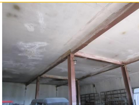
Фото 8. Состояние отделки помещений
