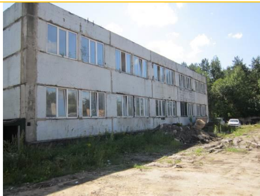
Фото 1. Общий вид здания
