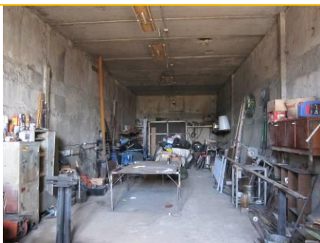
Фото 5. Состояние отделки помещений
