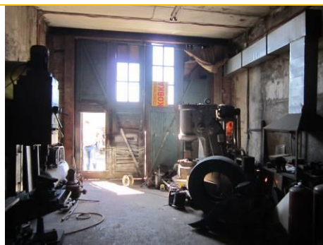
Фото 6. Состояние отделки помещений
