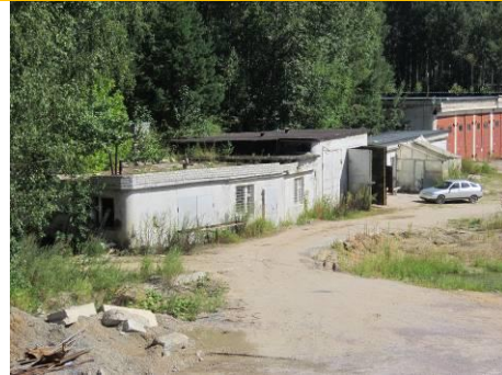
Фото 2. Общий вид здания
