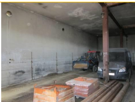
Фото 7. Состояние отделки помещений
