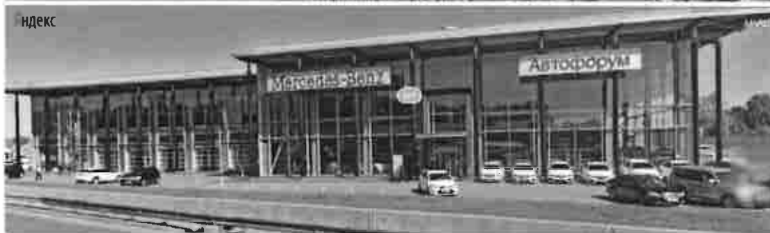
Аналог №3 Дилерский автосалон и автосервис Московская обл., Мытищи, 92-й км МКАД, вл.1
