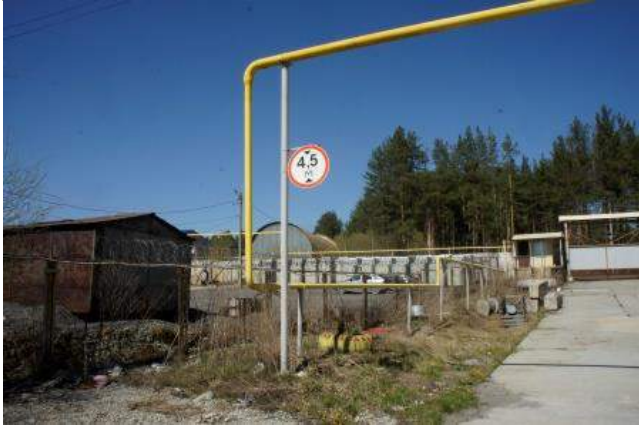
Сооружение – крытый склад металла, назначение: нежилое, общая площадь: 924 кв.м., инв. № 9923/01/0007/13-00, Адрес (местоположение): Российская Федерация, Свердловская область, г. Березовский, пос. Ленинский, д. 30.
