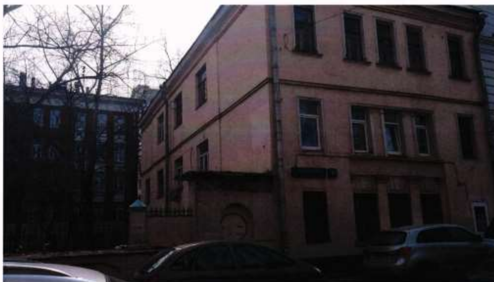
Фото № 8. Общий вид на службы по Барашевскому переулку.
