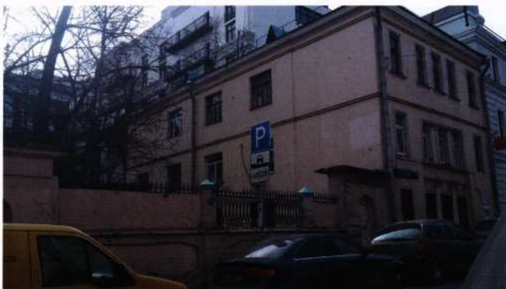
Фото № 6. Вид на главный фасад службы и ограды с воротами по Барашевскому переулку.
