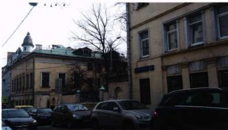
Фото № 12. Общий вид на усадьбу по Барашевскому переулку.
