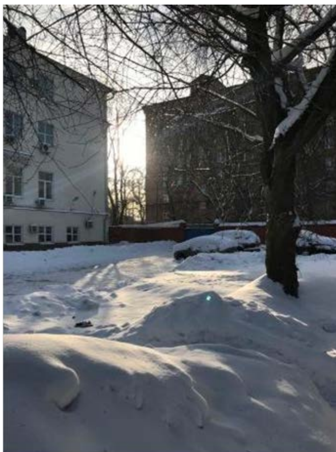
Территория внутреннего двора
