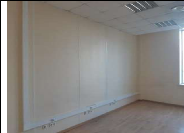
Техническое состояние объекта оценки
