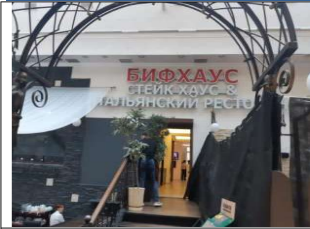
Техническое состояние объекта оценки
