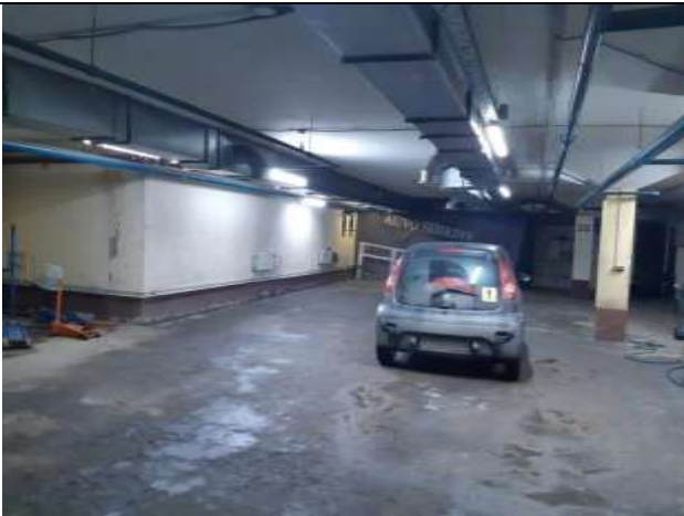
Техническое состояние объекта оценки
