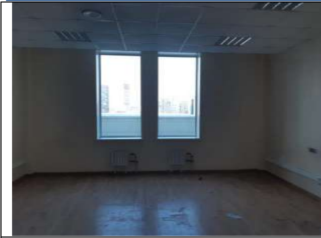
Техническое состояние объекта оценки
