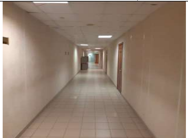
Техническое состояние объекта оценки
