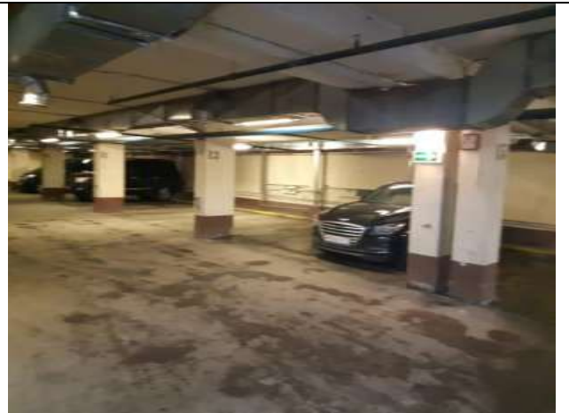
Техническое состояние объекта оценки
