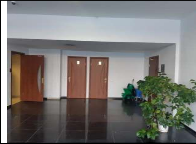
Техническое состояние объекта оценки
