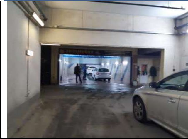
Техническое состояние объекта оценки
