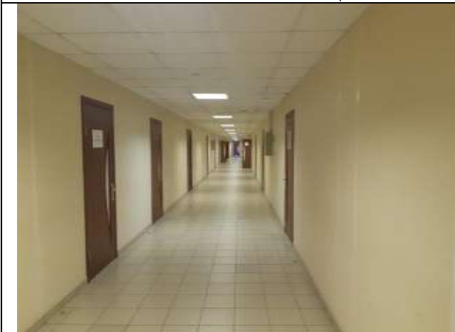
Техническое состояние объекта оценки
