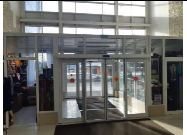
Техническое состояние объекта оценки
