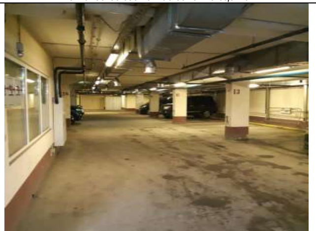
Техническое состояние объекта оценки
