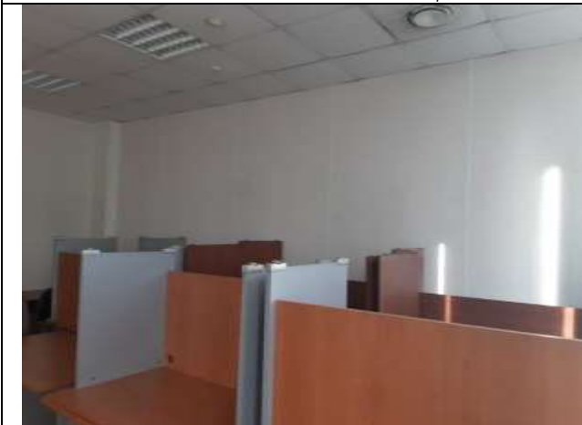
Техническое состояние объекта оценки
