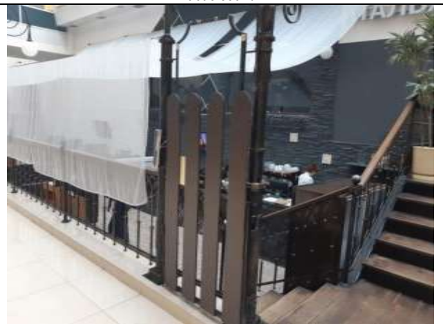
Техническое состояние объекта оценки
