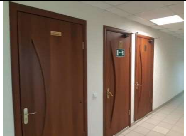
Техническое состояние объекта оценки
