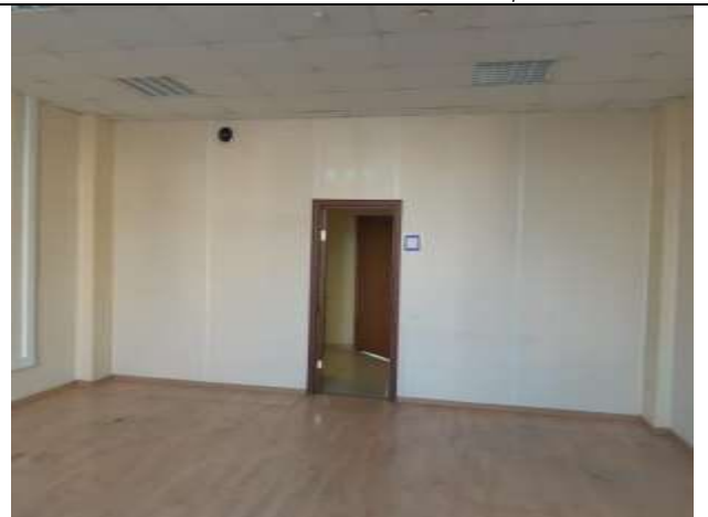
Техническое состояние объекта оценки
