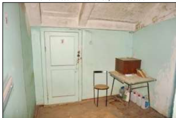
Фото 24 Состояние помещений подвала
