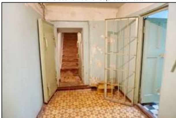
Фото 21 Состояние помещений подвала
