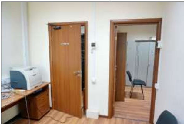
Фото 15 Состояние помещений 2 этажа
