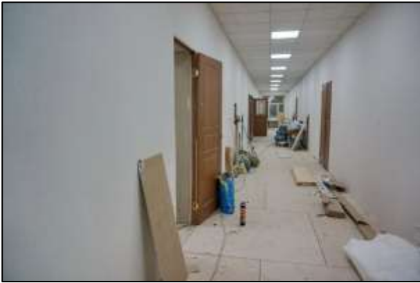
Фото 11. Состояние помещений 1 этажа
