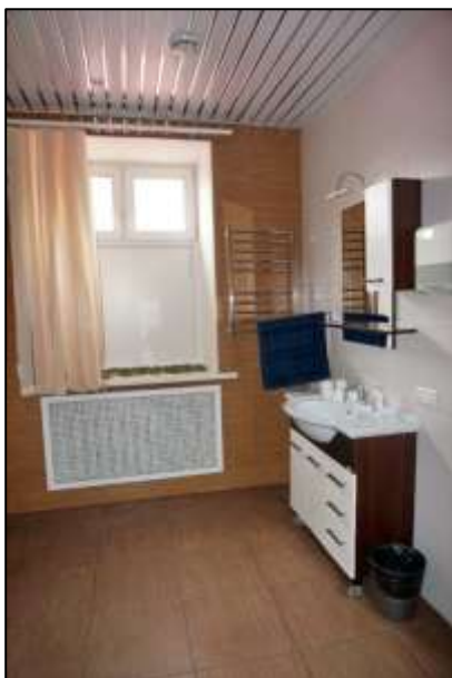
Фото 19 Состояние помещений 3 этажа
