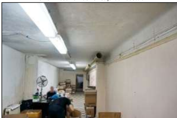
Фото 23 Состояние помещений подвала
