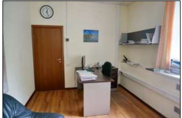
Фото 14 Состояние помещений 1 этажа
