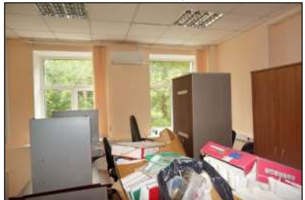
Фото 16 Состояние помещений 2 этажа
