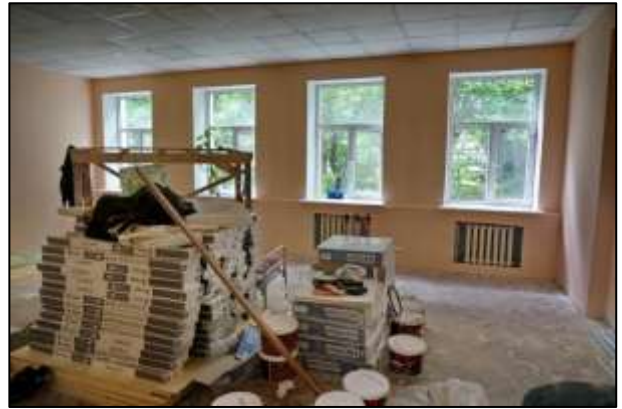
Фото 12. Состояние помещений 1 этажа
