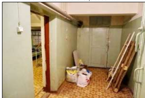
Фото 22 Состояние помещений подвала
