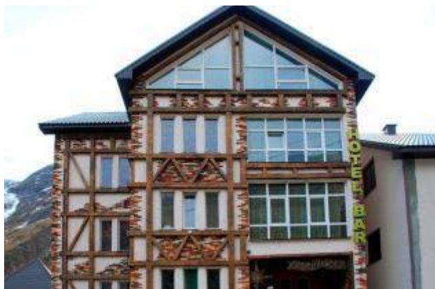
Фото 1. Главный фасад здания
