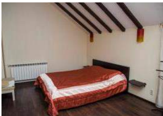
Фото 27. Состояние внутренней отделки помещений
