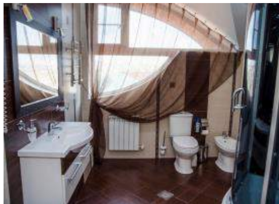
Фото 36. Состояние внутренней отделки помещений санузла
