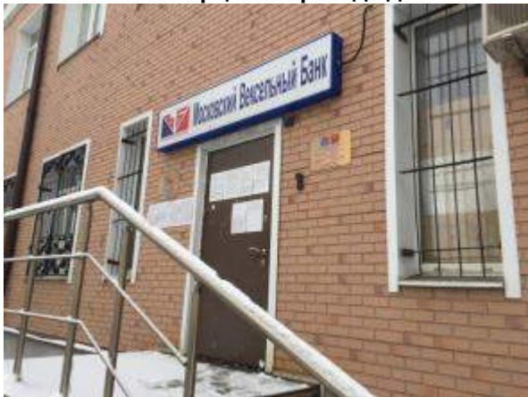
Фото 5. Вход в здание
