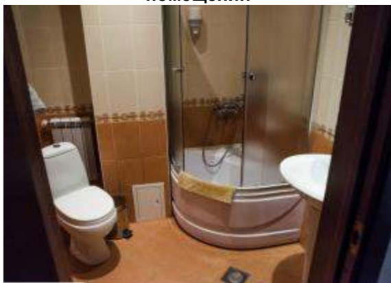
Фото 33. Состояние внутренней отделки помещений санузла
