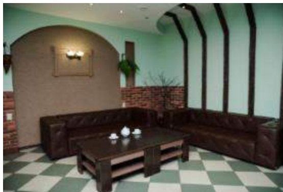
Фото 12. Состояние внутренней отделки помещений
