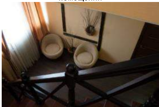
Фото 7. Состояние внутренней отделки помещений
