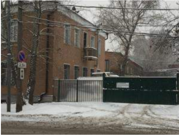
Фото 3. Торцевой фасад здания
