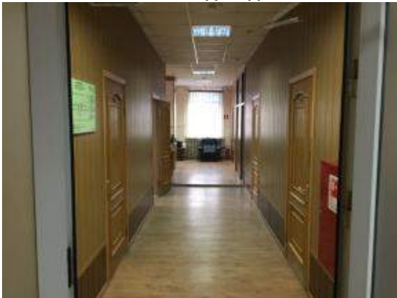
Фото 6. Состояние внутренней отделки помещений
