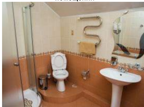
Фото 34. Состояние внутренней отделки помещений санузла
