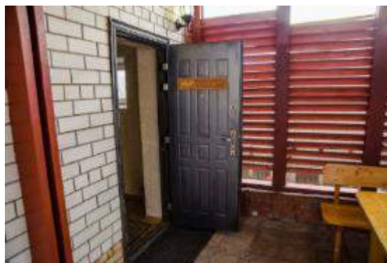
Фото 4. Вход в дом
