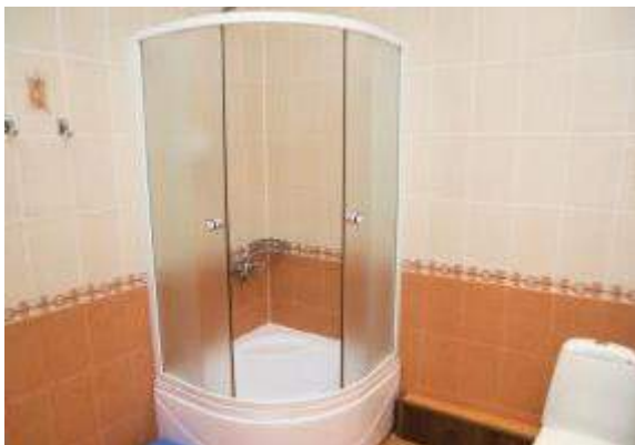
Фото 35. Состояние внутренней отделки помещений санузла
