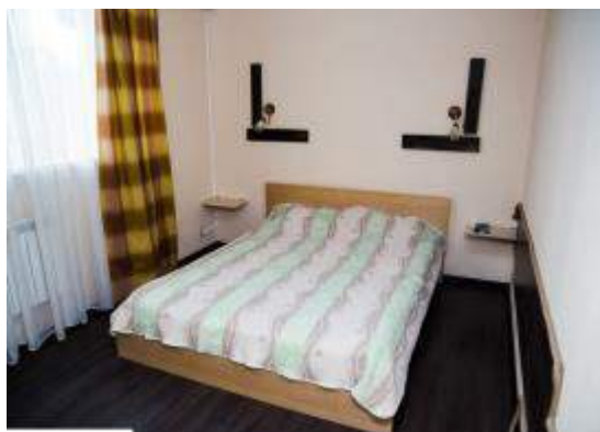
Фото 19. Состояние внутренней отделки помещений
