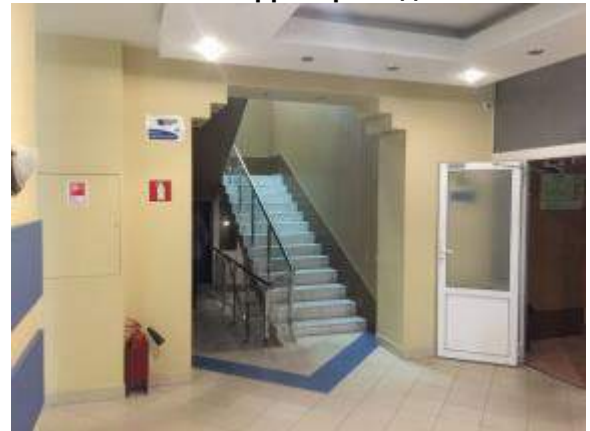
Фото 7. Состояние внутренней отделки помещений
