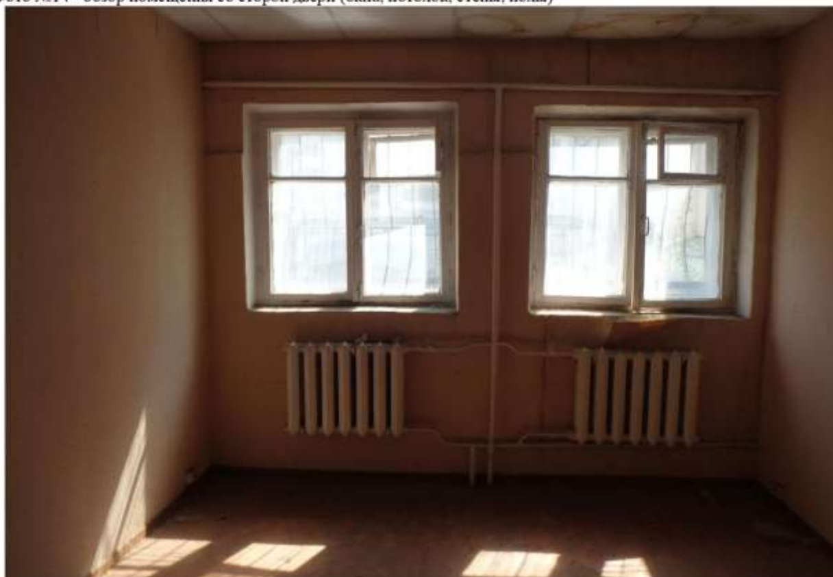
Фото №14 - обзор помещения со сторон двери (окна, потолок, стены, полы)
