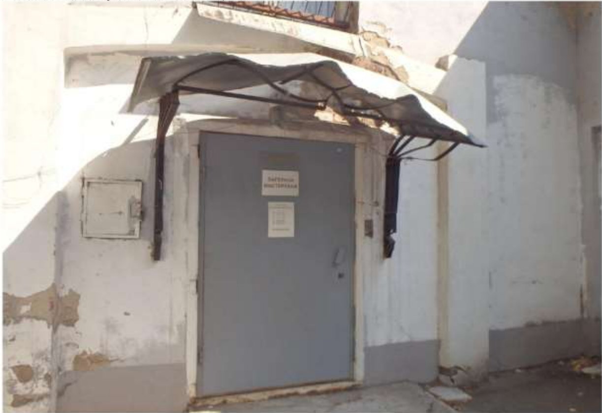
Фото №136 - используемый вход в здание (для помещения)
