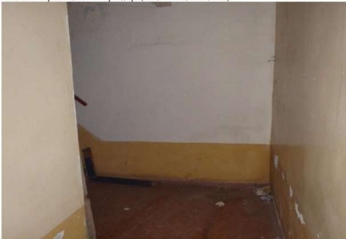
Фото №25 - обзор помещения со сторон двери (окна, потолок, стены, полы)
