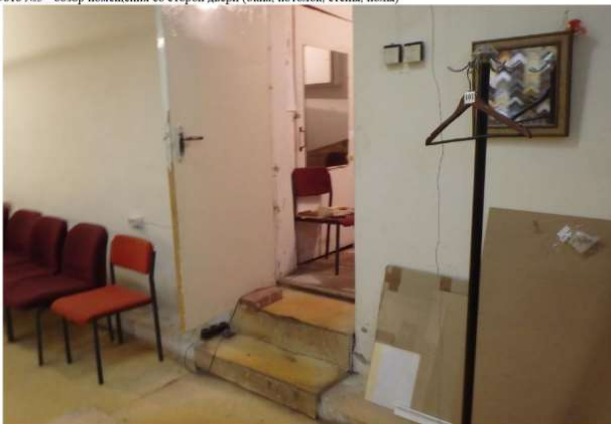
Фото №5 - обзор помещения со сторон двери (окна, потолок, стены, полы)
