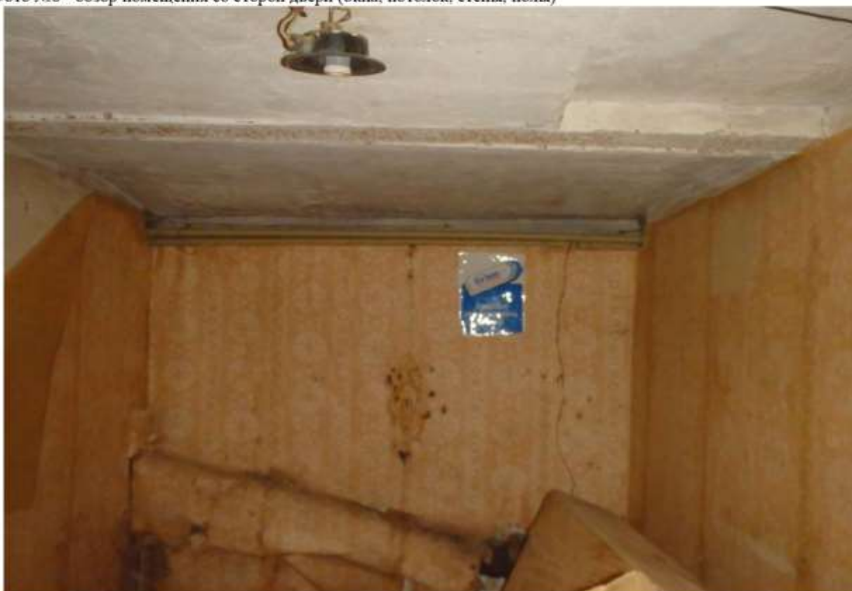
Фото №6 - обзор помещения со сторон двери (окна, потолок, стены, полы)
