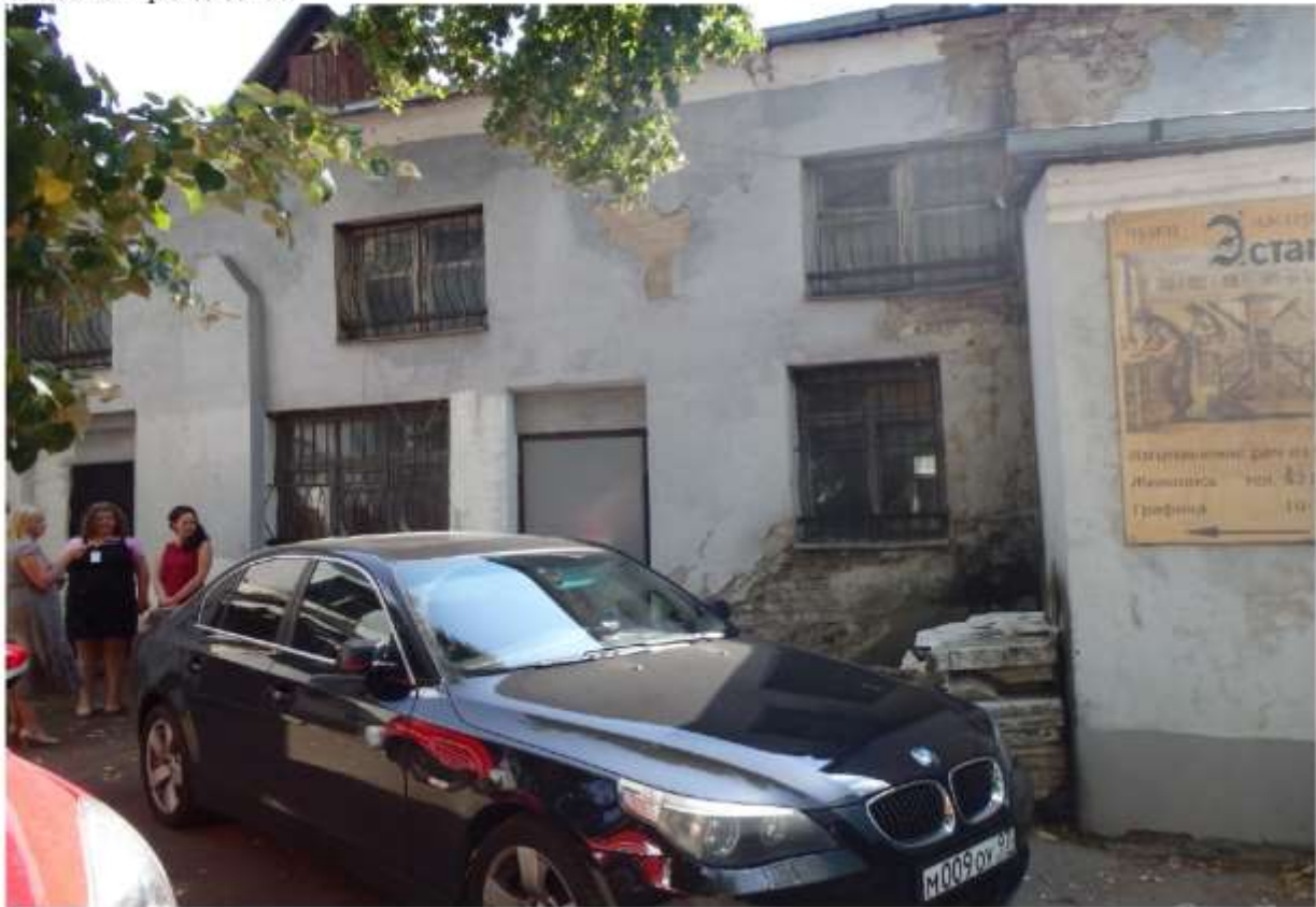
Фото №138 - фасад здания
