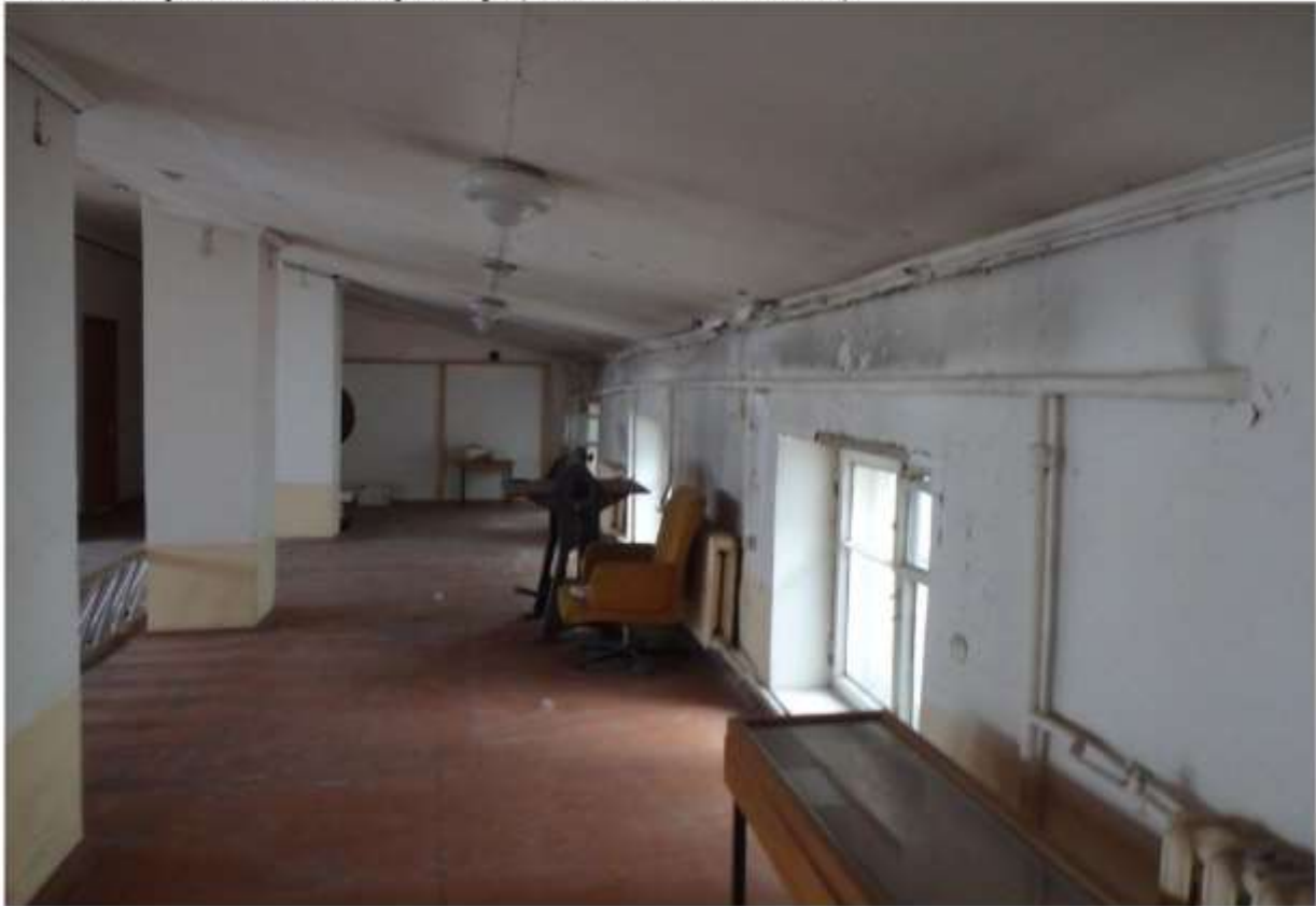
Фото №8 - обзор помещения со сторон двери (окна, потолок, стены, полы)
