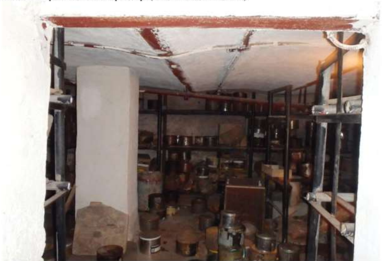
Фото №7 - обзор помещения со сторон двери (окна, потолок, стены, полы)
