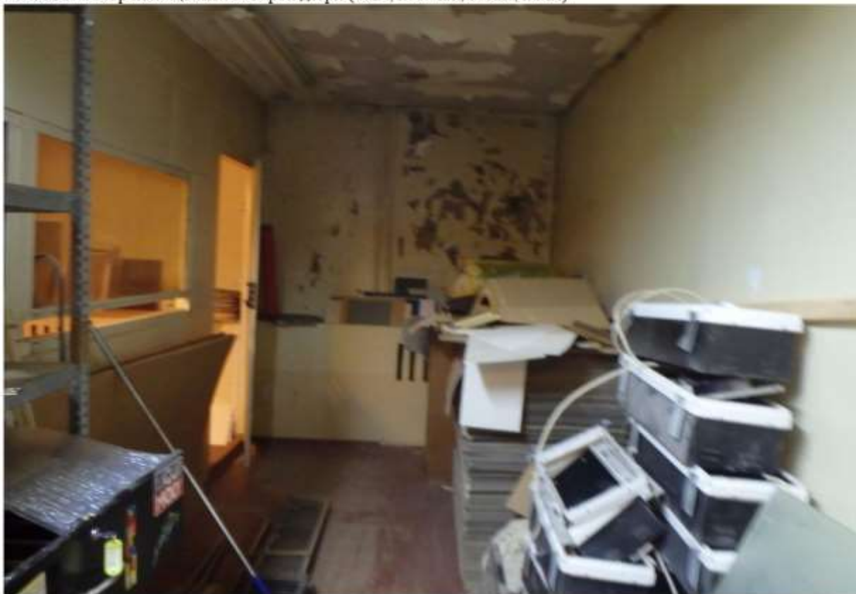
Фото №12 - обзор помещения со сторон двери (окна, потолок, стены, полы)
