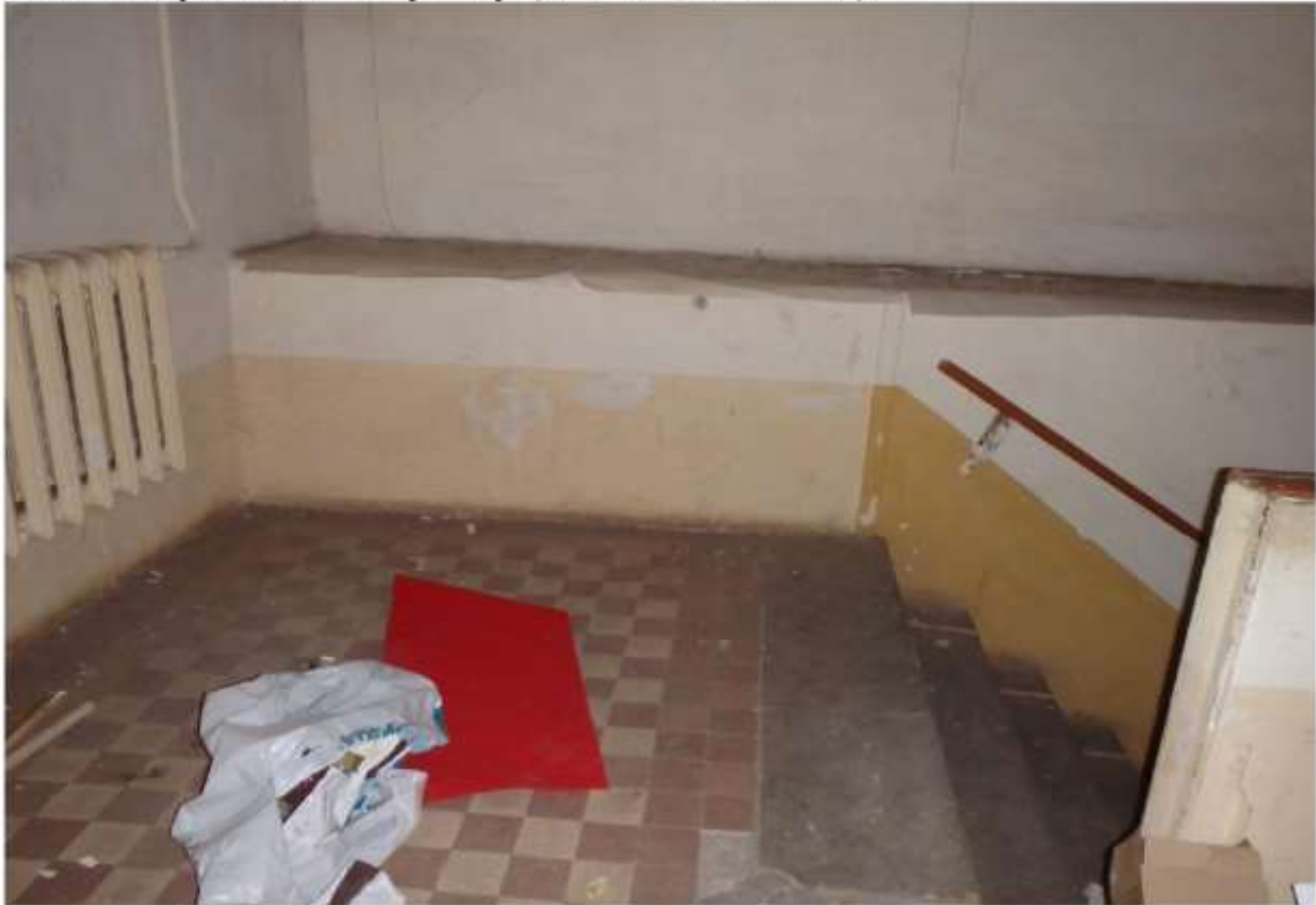
Фото №15 - обзор помещения со сторон двери (окна, потолок, стены, полы)
