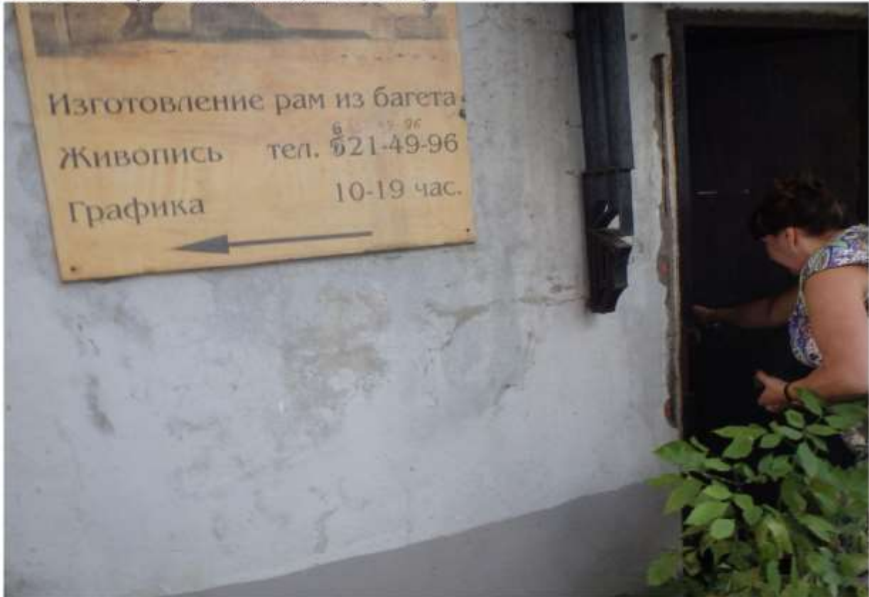
Фото №1 - используемый вход в здание (для помещения)
