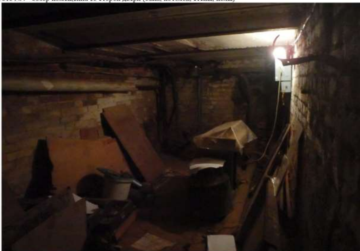
Фото №4 - обзор помещения со сторон двери (окна, потолок, стены, полы)
