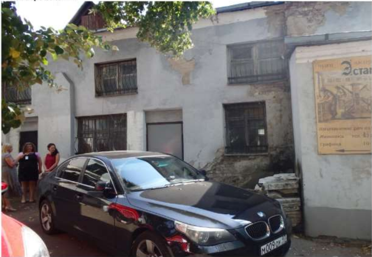
Фото №3 - фасад здания
