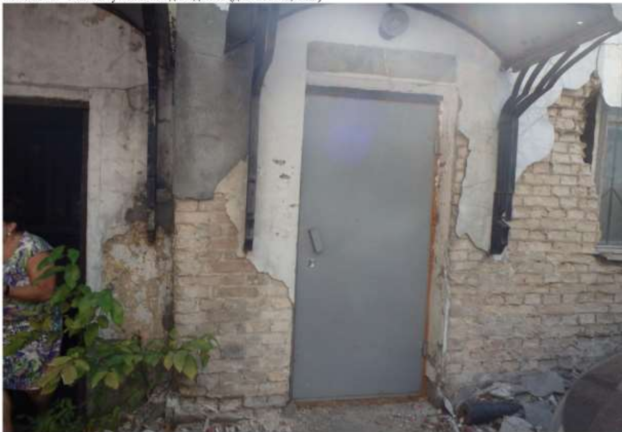
Фото №135 - используемый вход в здание (для помещения)
