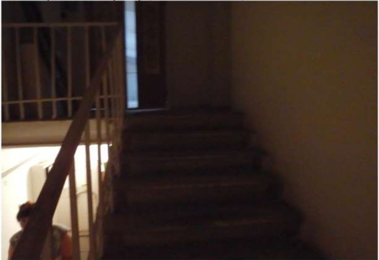
Фото №4 - обзор помещения со сторон двери (окна, потолок, стены, полы)
