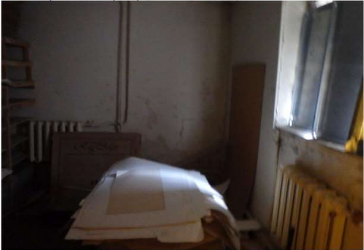
Фото №10 - обзор помещения со сторон двери (окна, потолок, стены, полы)
