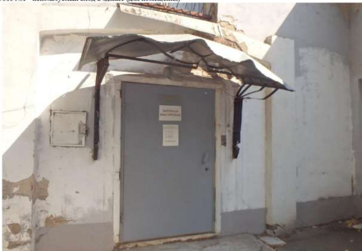
Фото №1 - используемый вход в здание (для помещения)
