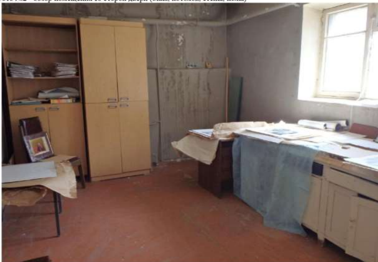
Фото №2 - обзор помещения со сторон двери (окна, потолок, стены, полы)
