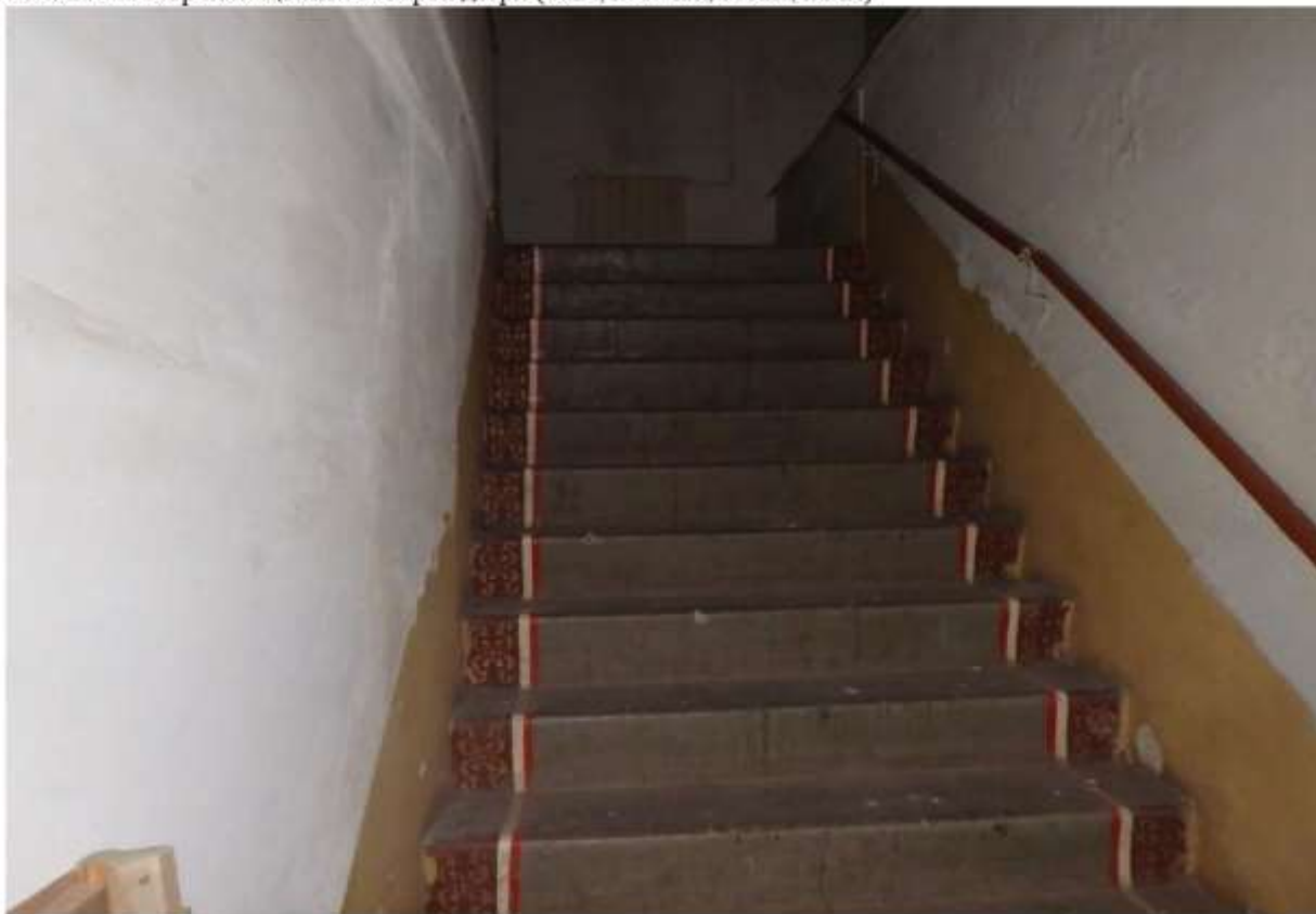
Фото №26 - обзор помещения со сторон двери (окна, потолок, стены, полы)
