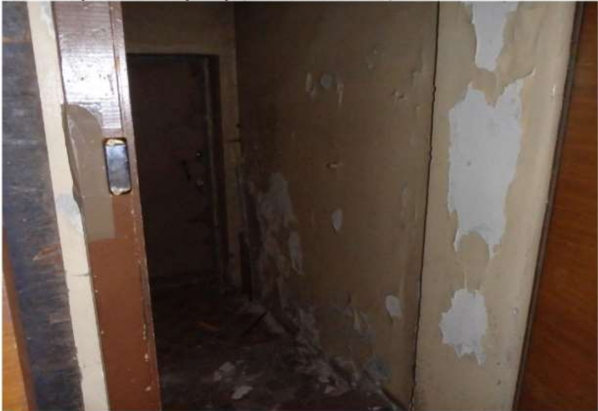
Фото №29 - обзор помещения со сторон двери (окна, потолок, стены, полы)
