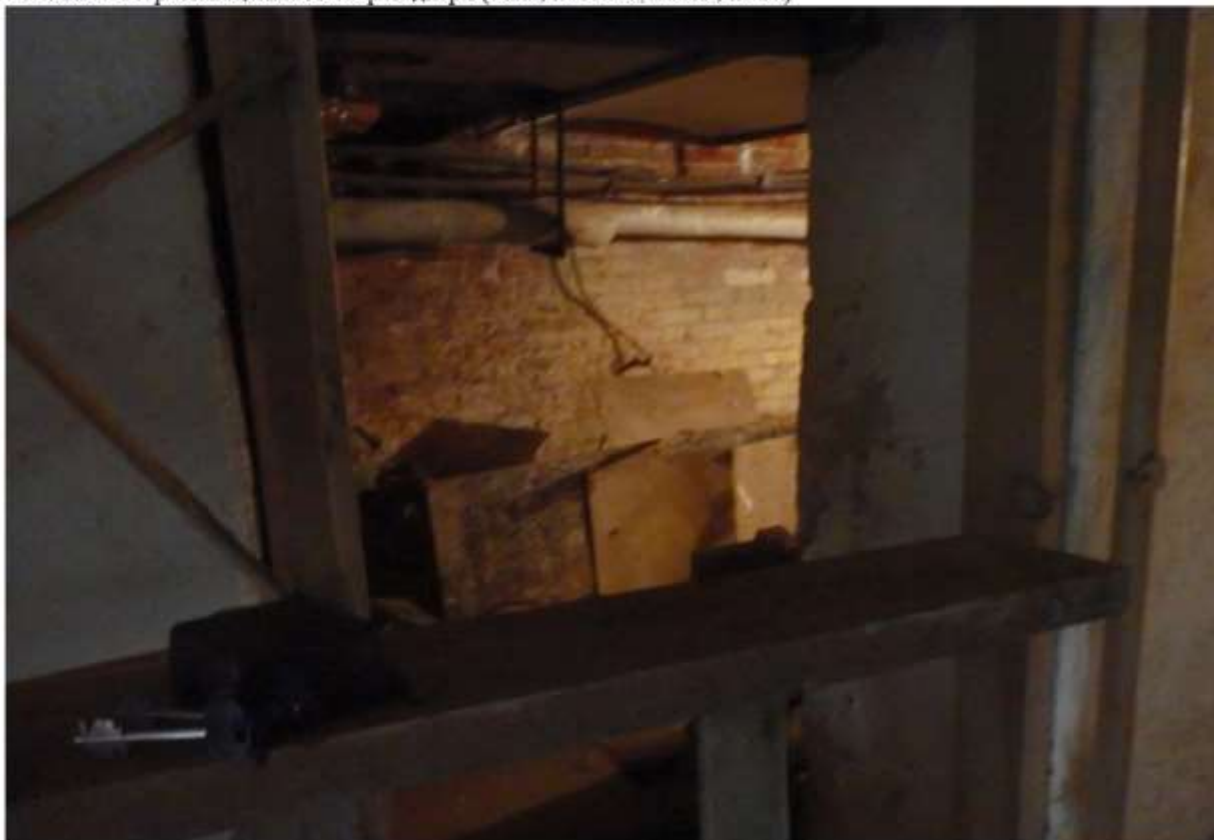
Фото №3 - обзор помещения со сторон двери (окна, потолок, стены, полы)
