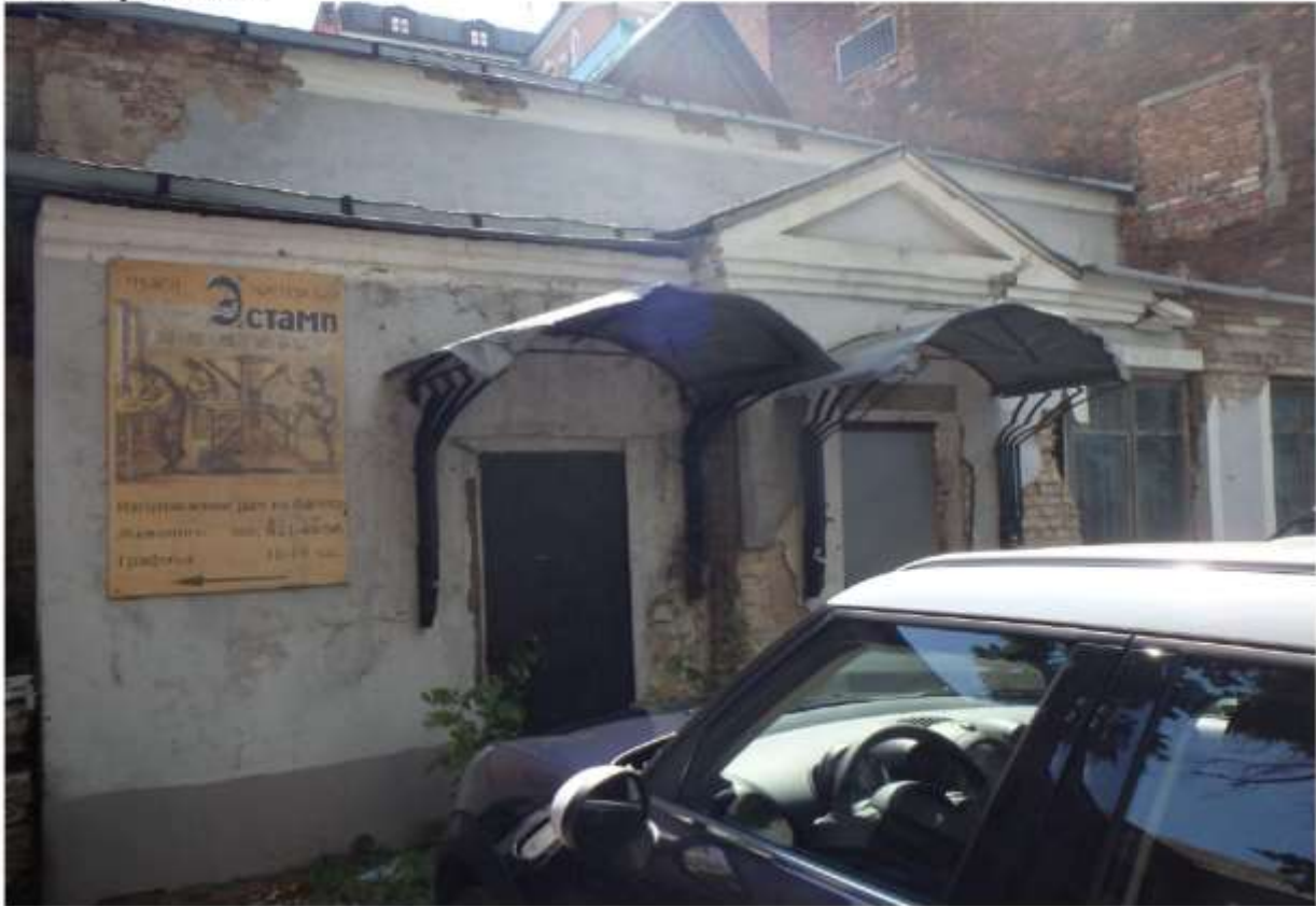
Фото №2 - фасад здания
