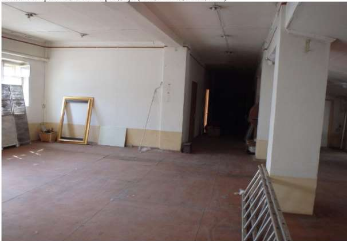
Фото №9 - обзор помещения со сторон двери (окна, потолок, стены, полы)
