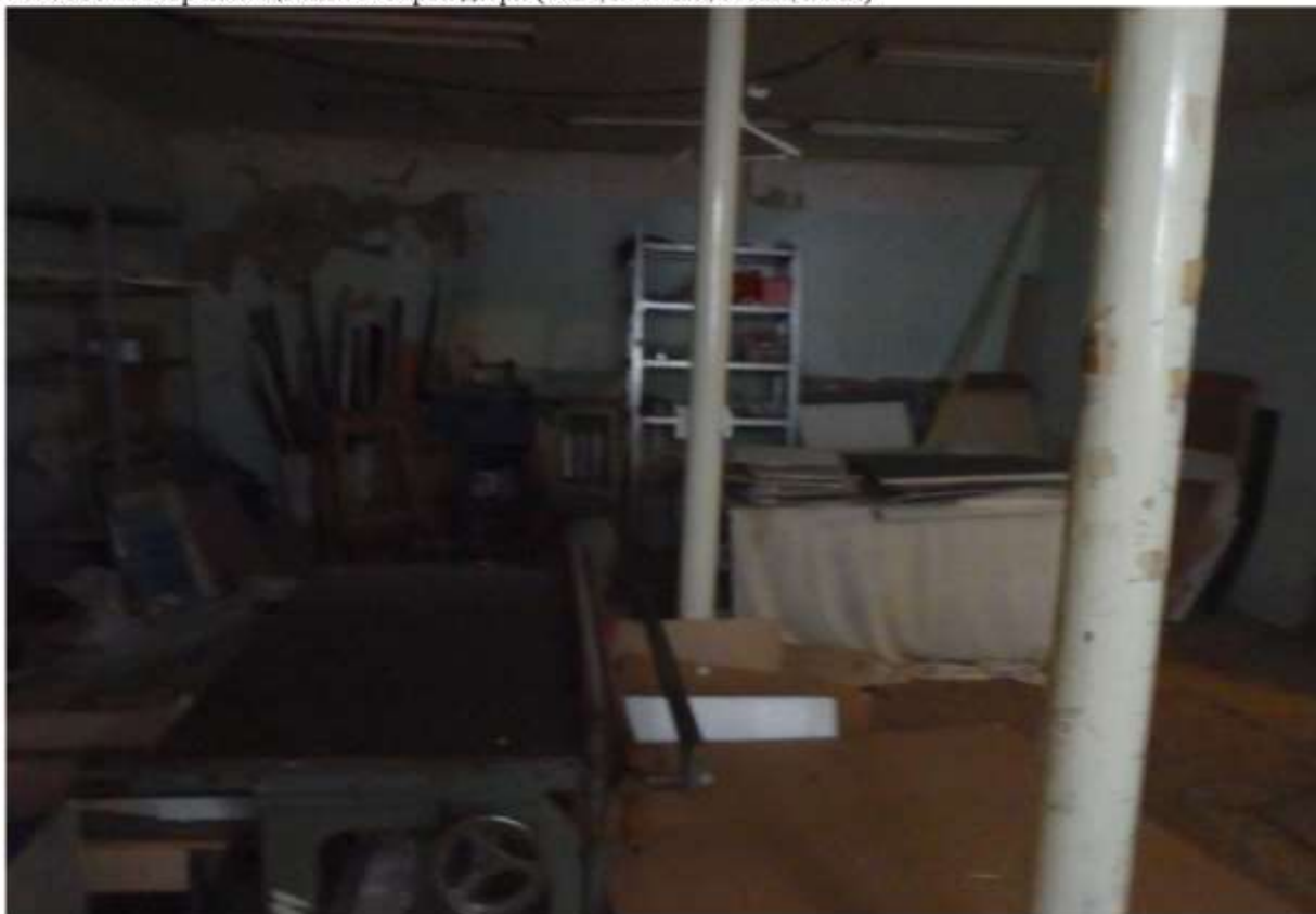
Фото №16 - обзор помещения со сторон двери (окна, потолок, стены, полы)
