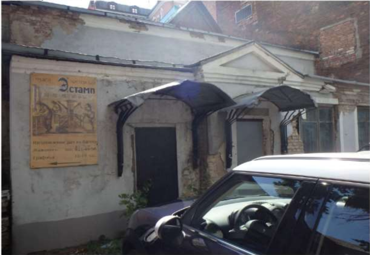
Фото №137 - фасад здания
