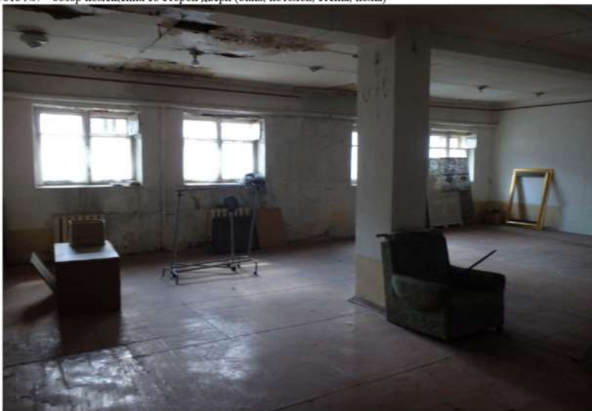
Фото №7 - обзор помещения со сторон двери (окна, потолок, стены, полы)
