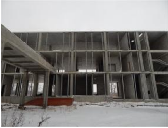
Состояние объектов незавершенного строительства
