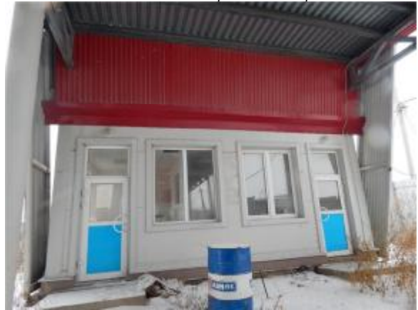
Состояние объектов незавершенного строительства
