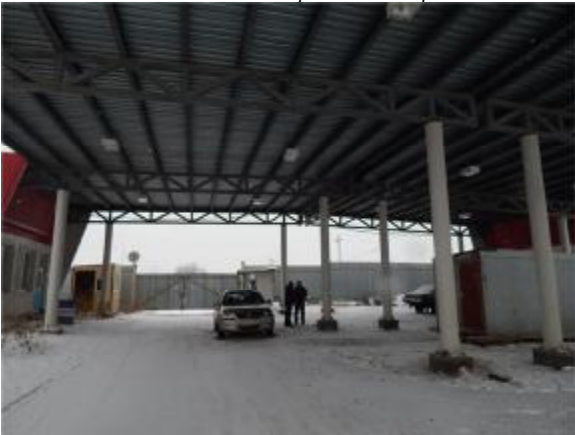
Состояние объектов незавершенного строительства
