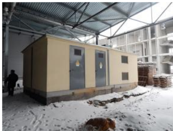
Состояние объектов незавершенного строительства Источник информации: данные визуального осмотра
