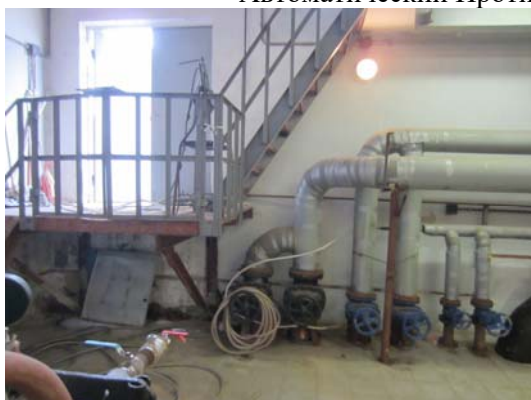
Автоматический Противопожарный водопровод
