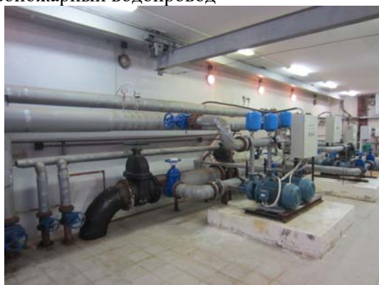
Автоматический Противопожарный водопровод
