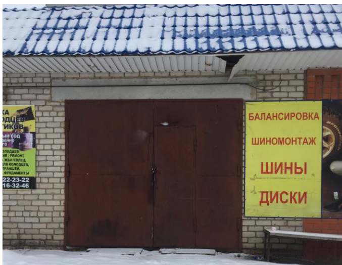
Внешний вид здания
