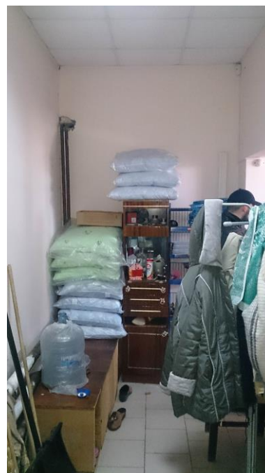
Состояние внутренней отделки (подсобные помещения)
