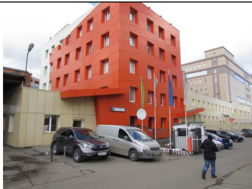
Рисунок 6.6 Внешний вид здания
