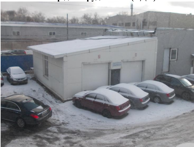
Ангар дооборудования (АДО)
