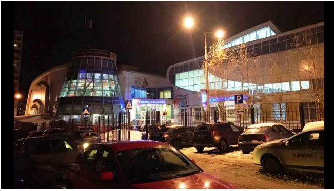
Фото 1. Общий вид здания
