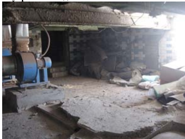
Фото 32. Здание бетоносмесительного цеха: внутренний вид
