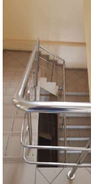
Фото №10: Лестничная площадка
