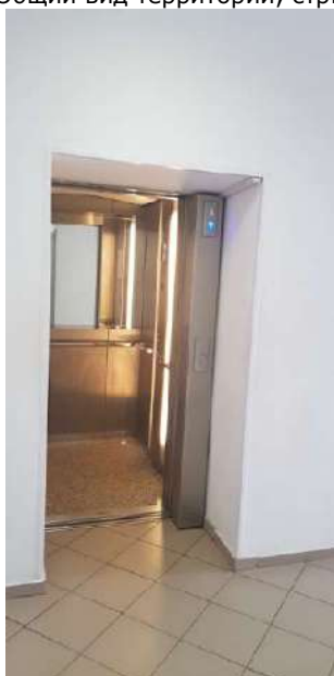
Фото №7: Площадка перед лифтом
