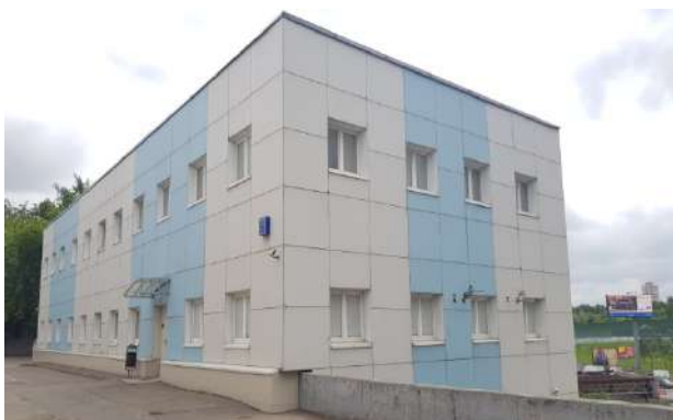
Фото №1: Строение 21 – общий вид
