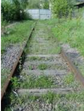
Рис. 9.58 Железнодорожные пути 561 кв. м.
