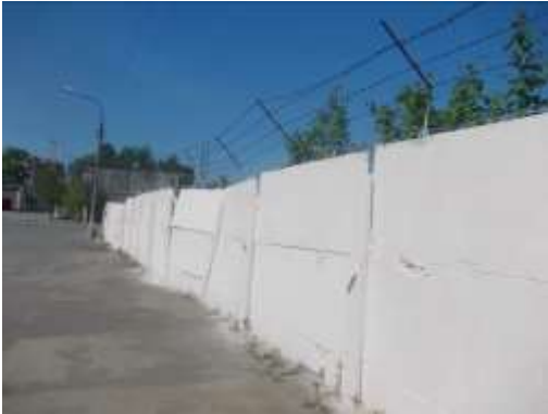
Рис. 9.62 Забор из ж/б плит протяженностью 732,55 м., протяженностью 94,6 м.
