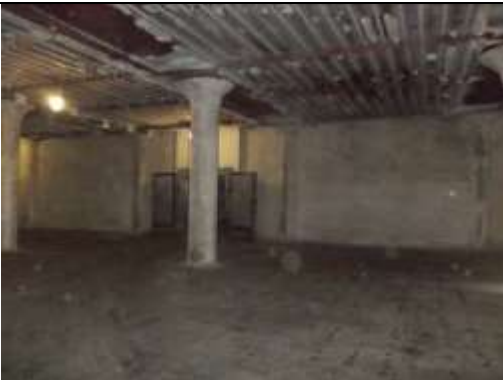
Рис. 9.24 Здание главный корпус (здание холодильника), пристройка к производственному участку, тамбур, 15 226 кв. м
