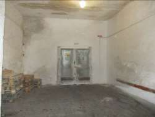
Рис. 9.22 Здание главный корпус (здание холодильника), пристройка к производственному участку, тамбур, 15 226 кв. м
