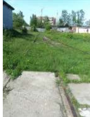
Рис. 9.59 Железнодорожные пути 561 кв. м.
