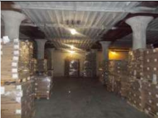
Рис. 9.20 Здание главный корпус (здание холодильника), пристройка к производственному участку, тамбур, 15 226 кв. м
