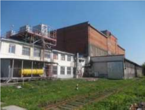
Рис. 9.14 Здание главный корпус (здание холодильника), пристройка к производственному участку, тамбур, 15 226 кв. м
