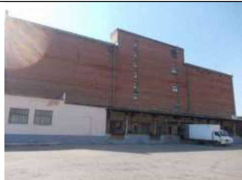
Рис. 9.17 Здание главный корпус (здание холодильника), пристройка к производственному участку, тамбур, 15 226 кв. м
