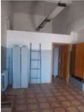
Рис. 9.54 Здание автовесовой, 133,4 кв. м.
