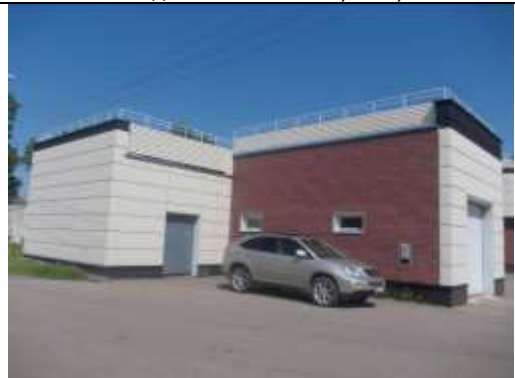
Рис. 9.53 Здание автовесовой, 133,4 кв. м.
