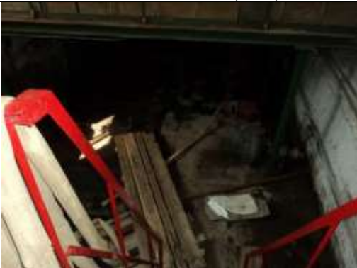
Рис. 9.40 Здание насосной, 118,5 кв. м
