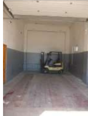
Рис. 9.55 Здание автовесовой, 133,4 кв. м.
