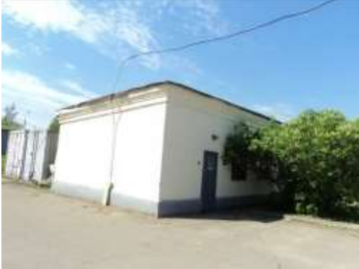
Рис. 9.38 Здание насосной, 118,5 кв. м
