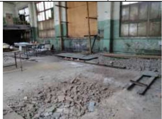
Рис. 9.51 Здание котельной, 571,1 кв. м.
