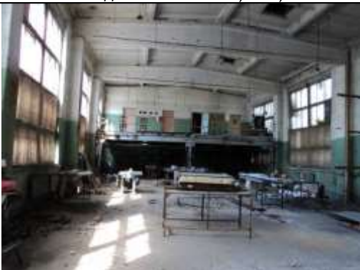
Рис. 9.50 Здание котельной, 571,1 кв. м.
