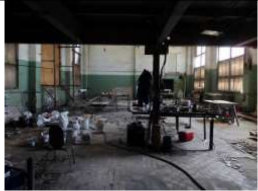
Рис. 9.49 Здание котельной, 571,1 кв. м.
