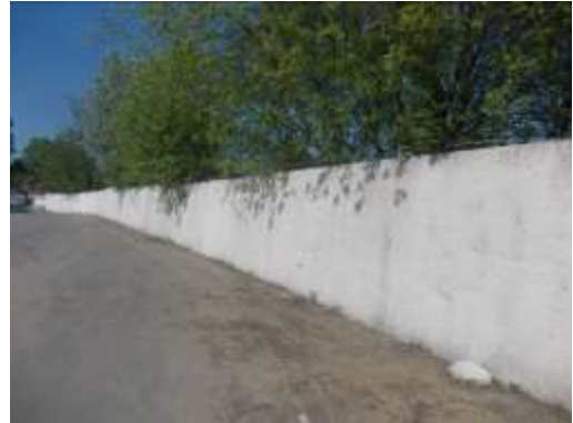
Рис. 9.63 Забор из ж/б плит протяженностью 732,55 м., протяженностью 94,6 м.
