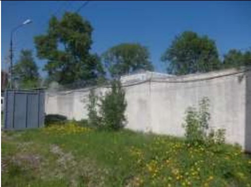
Рис. 9.60 Забор из ж/б плит протяженностью 732,55 м., протяженностью 94,6 м.
