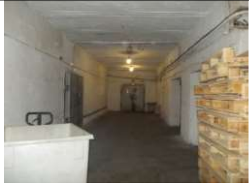
Рис. 9.31 Здание главный корпус (здание холодильника), пристройка к производственному участку, тамбур, 15 226 кв. м
