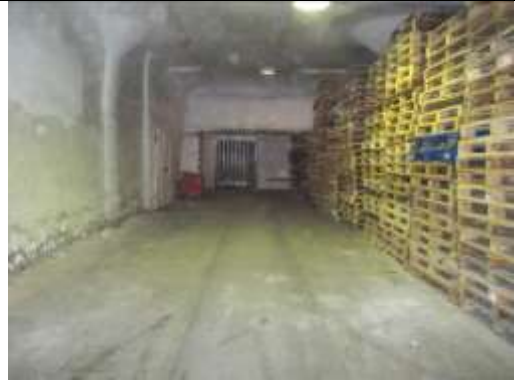
Рис. 9.33 Здание главный корпус (здание холодильника), пристройка к производственному участку, тамбур, 15 226 кв. м
