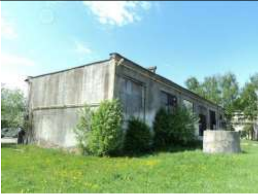
Рис. 9.48 Здание котельной, 571,1 кв. м.
