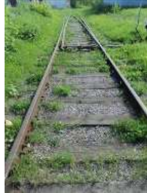
Рис. 9.57 Железнодорожные пути 561 кв. м.
