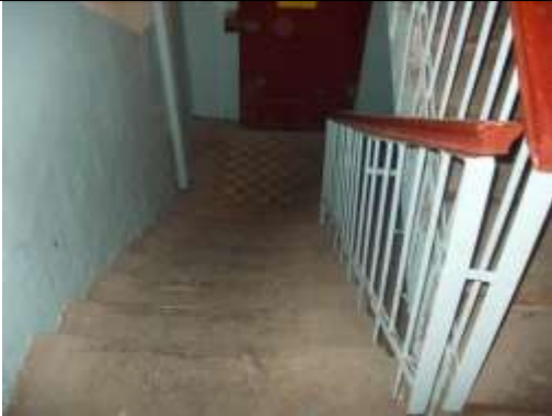
Рис. 9.32 Здание главный корпус (здание холодильника), пристройка к производственному участку, тамбур, 15 226 кв. м
