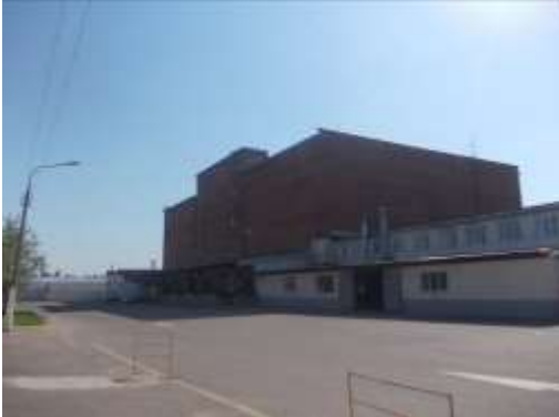
Рис. 9.18 Здание главный корпус (здание холодильника), пристройка к производственному участку, тамбур, 15 226 кв. м
