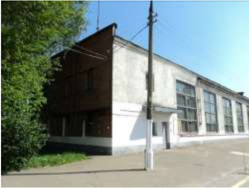
Рис. 9.46 Здание котельной, 571,1 кв. м.
