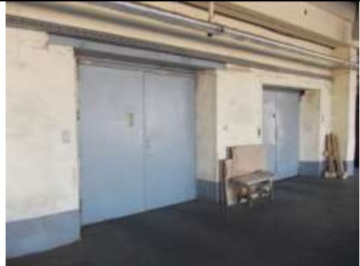
Рис. 9.37 Здание главный корпус (здание холодильника),
