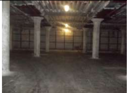
Рис. 9.27 Здание главный корпус (здание холодильника), пристройка к производственному участку, тамбур, 15 226 кв. м
