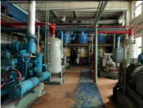
Рис. 9.36 Здание главный корпус (здание холодильника),
