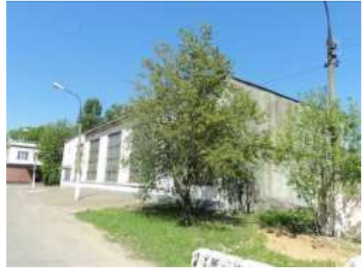
Рис. 9.47 Здание котельной, 571,1 кв. м.
