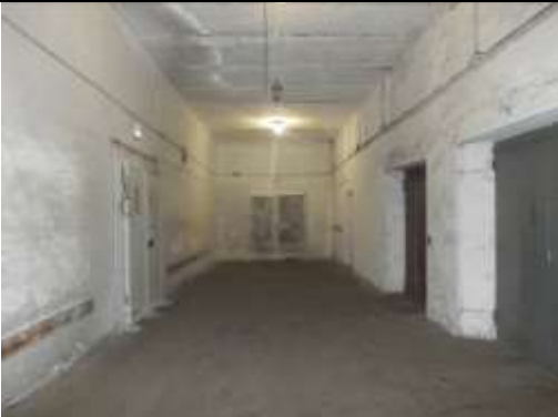
Рис. 9.28 Здание главный корпус (здание холодильника), пристройка к производственному участку, тамбур,
