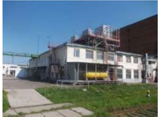
Рис. 9.15 Здание главный корпус (здание холодильника), пристройка к производственному участку, тамбур, 15 226 кв. м
