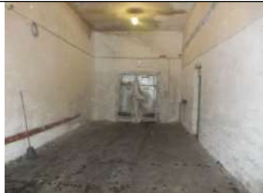
Рис. 9.21 Здание главный корпус (здание холодильника), пристройка к производственному участку, тамбур, 15 226 кв. м
