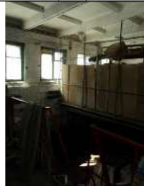
Рис. 9.41 Здание насосной, 118,5 кв. м
