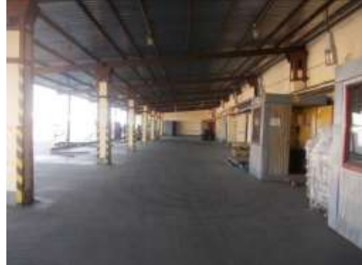
Рис. 9.19 Здание главный корпус (здание холодильника), пристройка к производственному участку, тамбур, 15 226 кв. м
