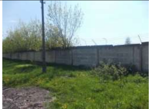
Рис. 9.61 Забор из ж/б плит протяженностью 732,55 м., протяженностью 94,6 м.
