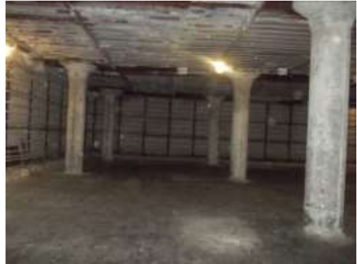
Рис. 9.23 Здание главный корпус (здание холодильника), пристройка к производственному участку, тамбур, 15 226 кв. м
