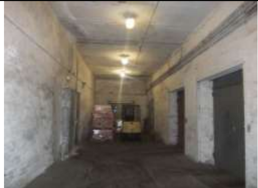
Рис. 9.29 Здание главный корпус (здание холодильника), пристройка к производственному участку, тамбур,
