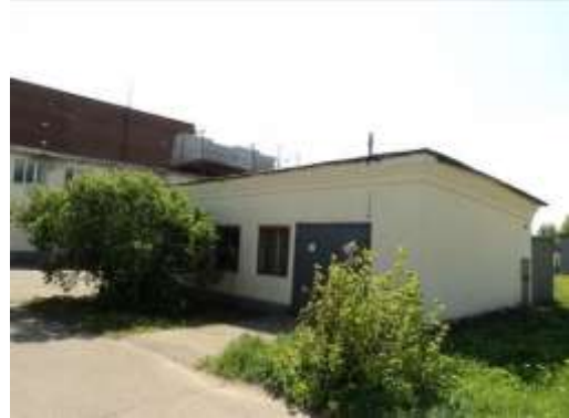
Рис. 9.39 Здание насосной, 118,5 кв. м
