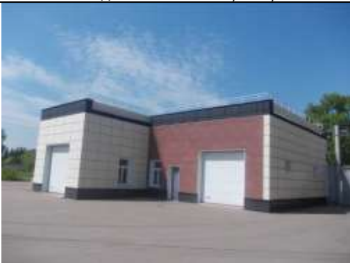
Рис. 9.52 Здание автовесовой, 133,4 кв. м.
