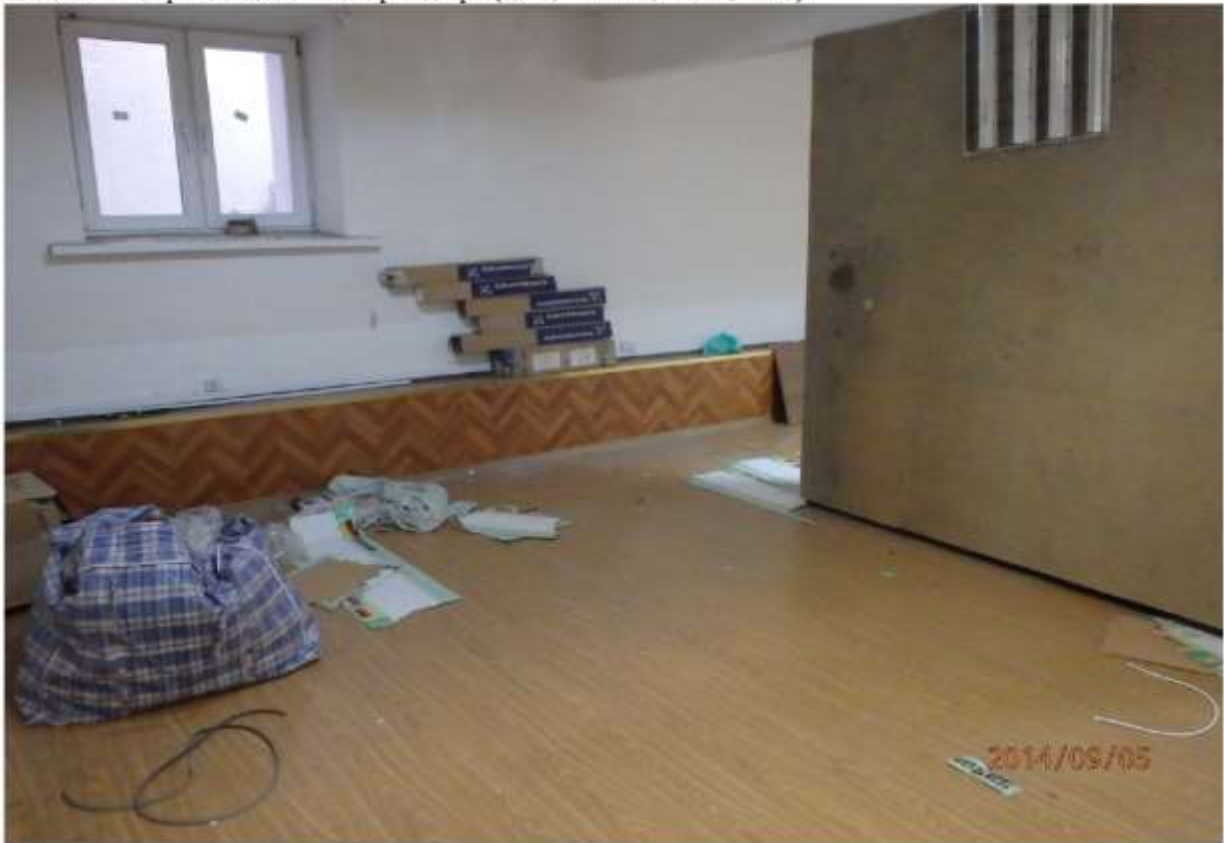
Фото №30 - обзор помещения со сторон двери (окна, потолок, стены, полы)
