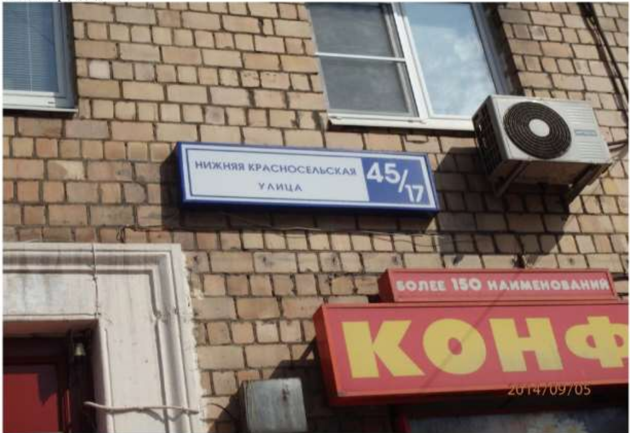
Фото №4 - фасад здания
