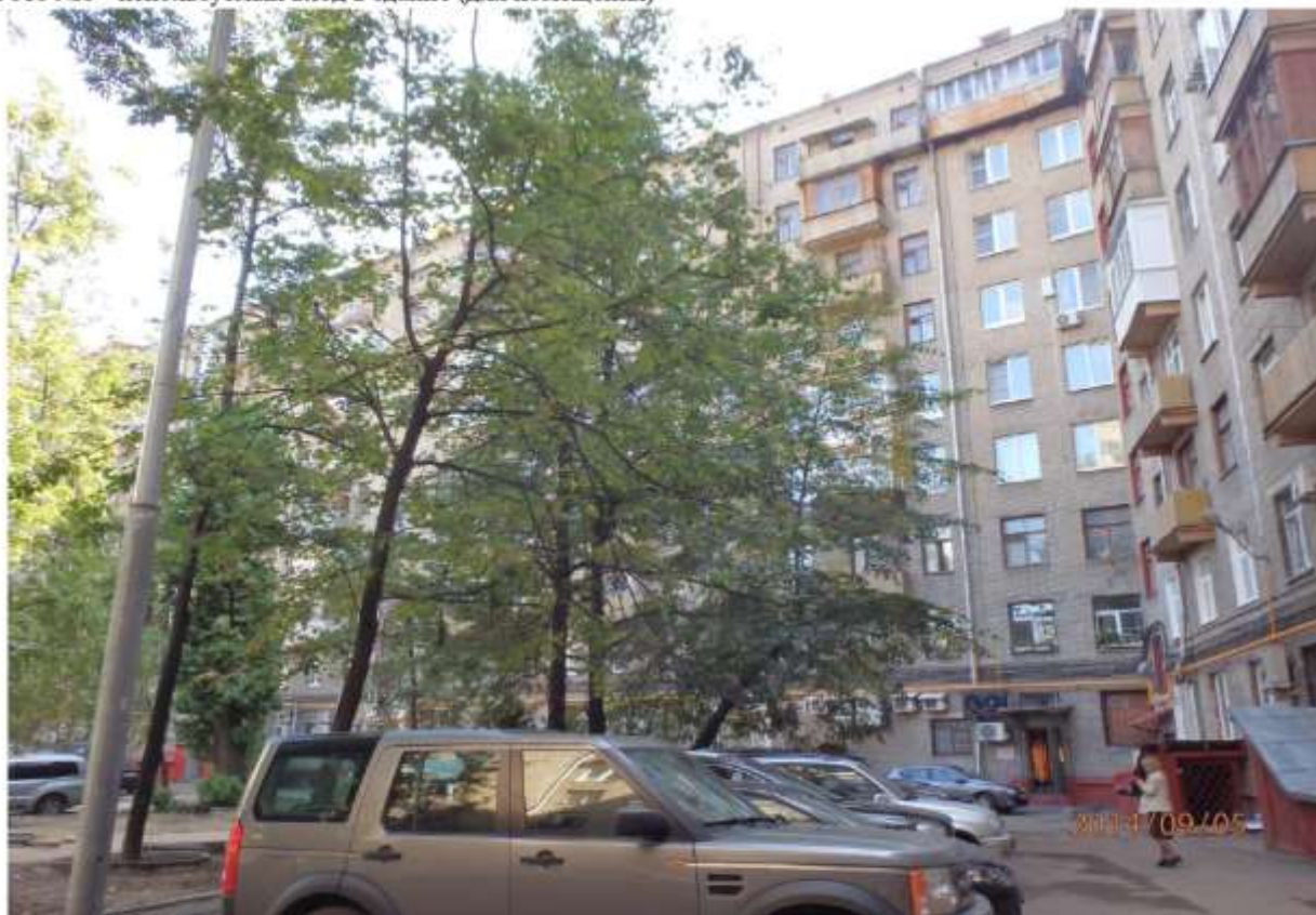
Фото №8 - используемый вход в здание (для помещения)
