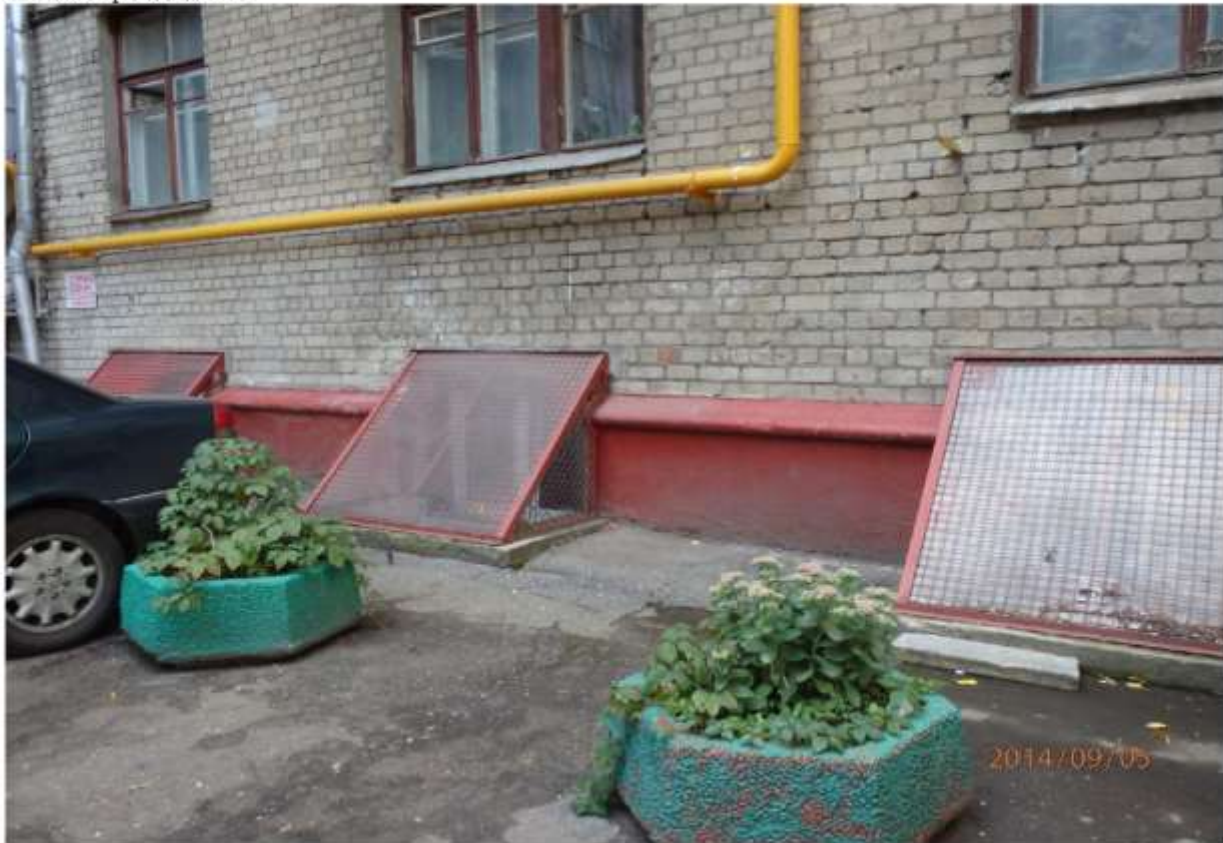
Фото №3 - фасад здания
