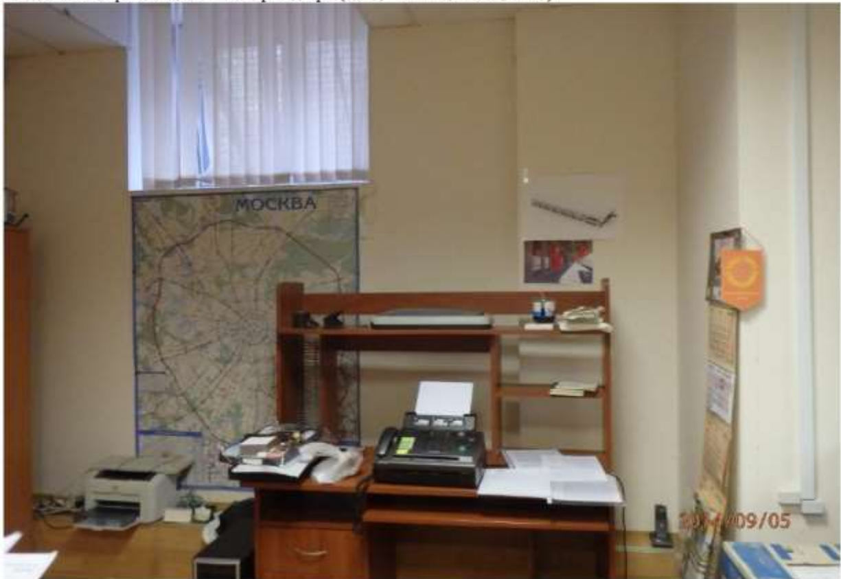
Фото №17 - обзор помещения со сторон двери (окна, потолок, стены, полы)
