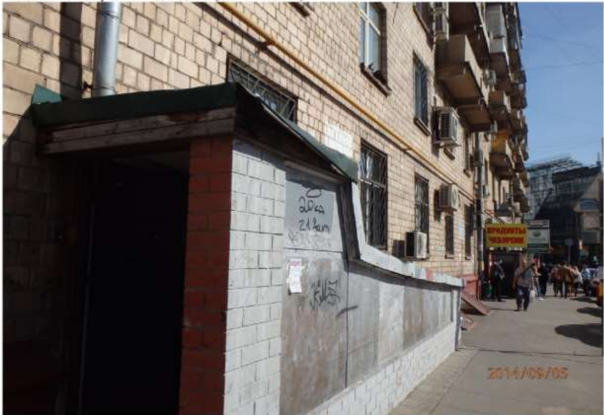
Фото №32 - используемый вход в здание (для помещения)
