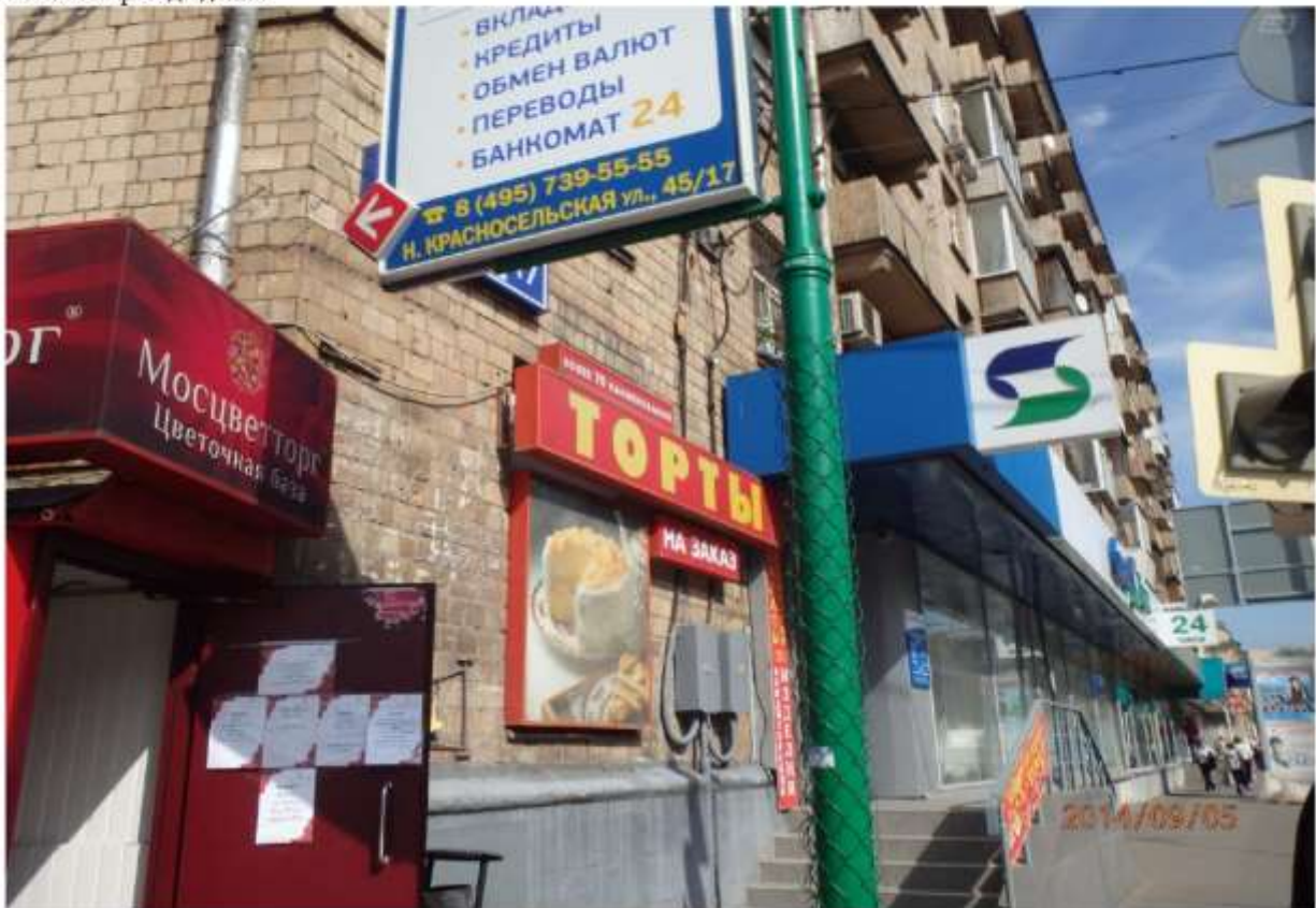
Фото №5 - фасад здания
