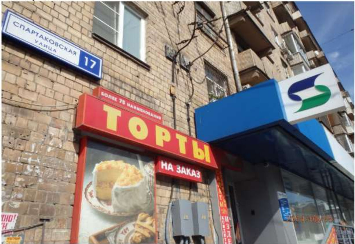
Фото №6 - фасад здания
