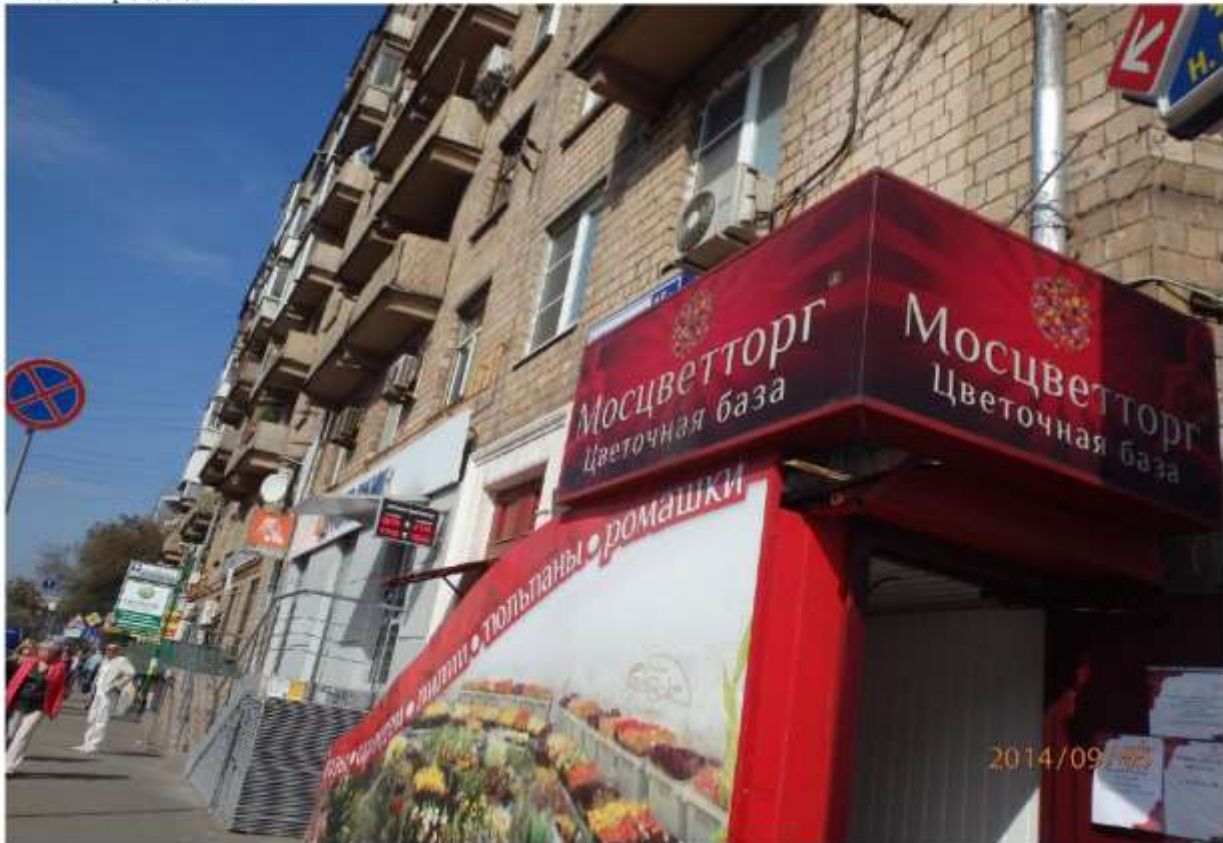
Фото №7 - фасад здания
