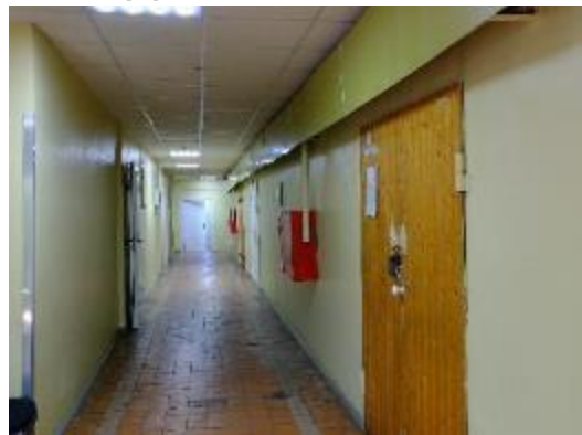
Фото 3.6. Внутренняя отделка здания
