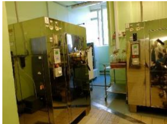
Фото 3.8. Внутренняя отделка здания
