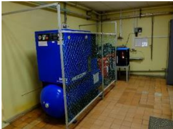
Фото 3.7. Внутренняя отделка здания
