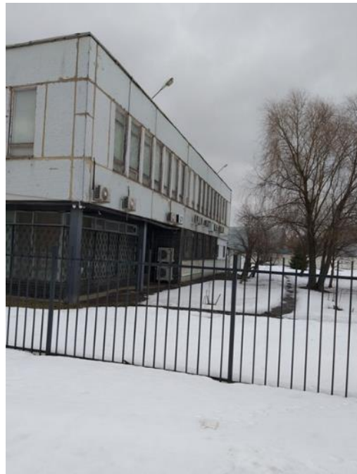
Фото 3.2. Внешний вид здания
