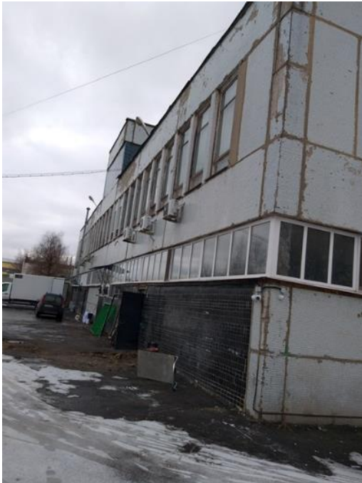
Фото 3.3. Внешний вид здания
