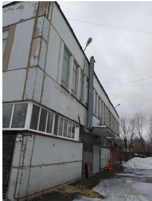
Фото 3.4. Внешний вид здания
