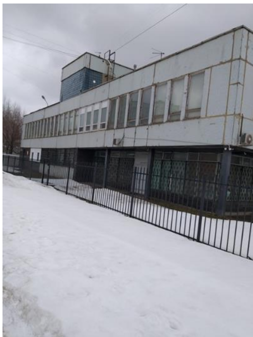
Фото 3.1. Внешний вид здания
