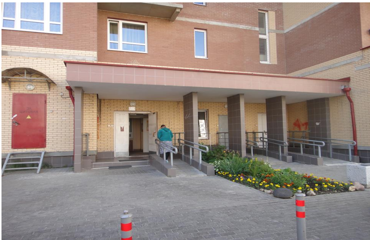
Фото 2. Вход в подвезд жилого дома
