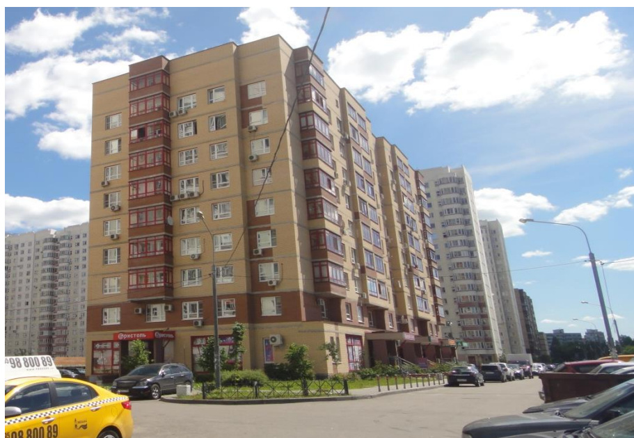
Фото 1. Общий вид жилого дома
