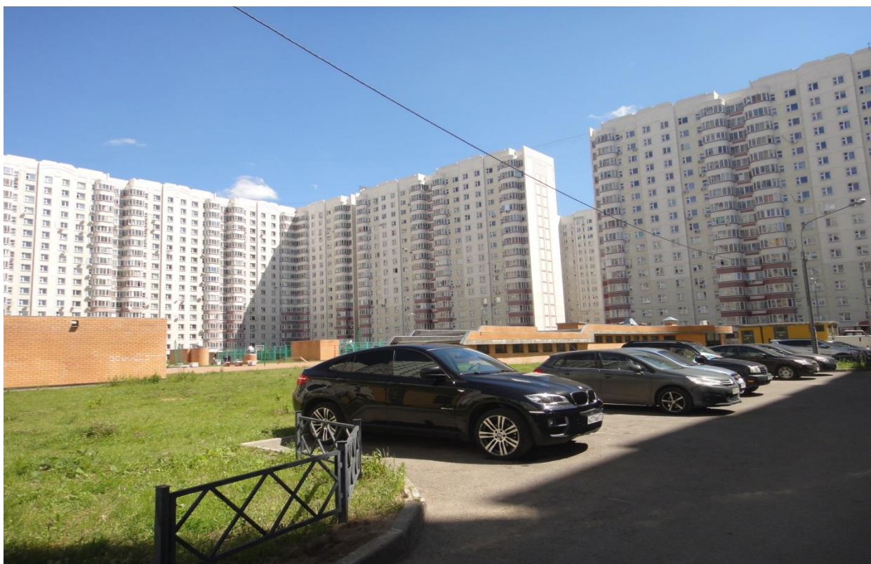
Фото 3. Двор и прилегающая территория жилого дома
