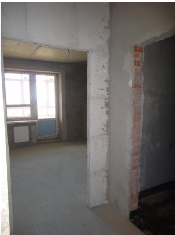
Фото 6. Вход на кухню и санузел
