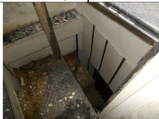
Лестница на второй этаж
