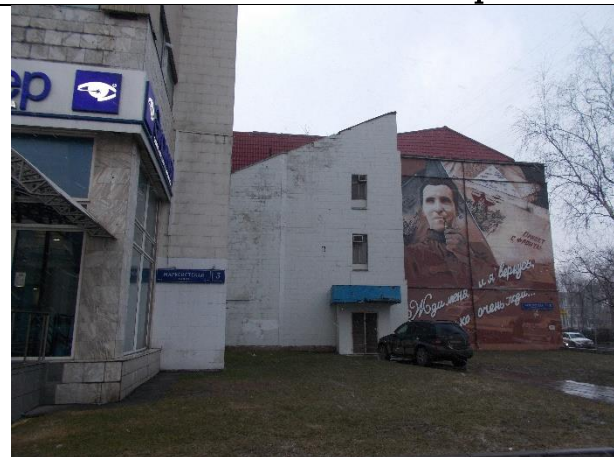
Фасад здания по ул. Марксистская
