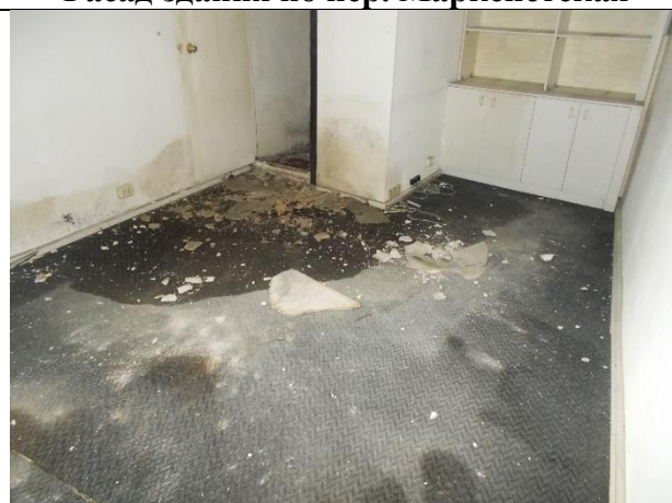
Протечки на втором этаже
