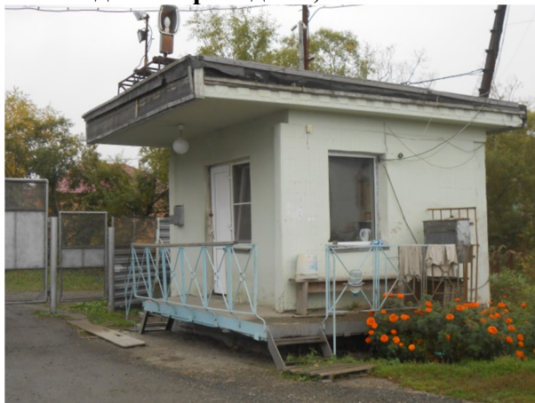
Здание проходной, лит. Л
