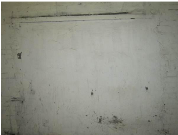
Фото 13. Забетонированный проход в ч.п. 1
