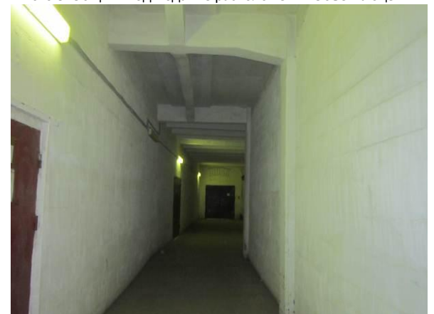
Фото 10. Общий вход в объект оценки на 3-м этаже
