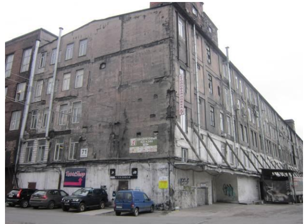
Фото 2. Фасад здания корпус 71
