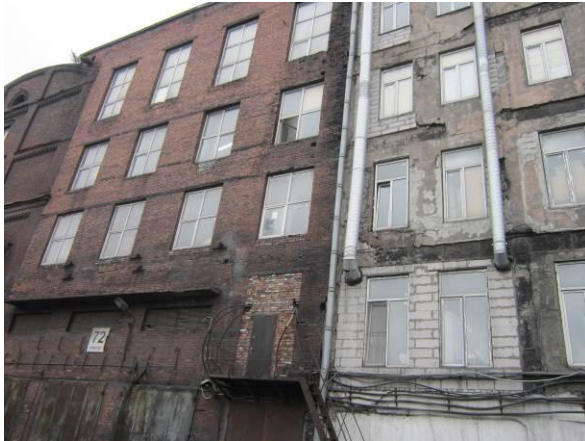
Фото 1. Фасад здания корпус 72
