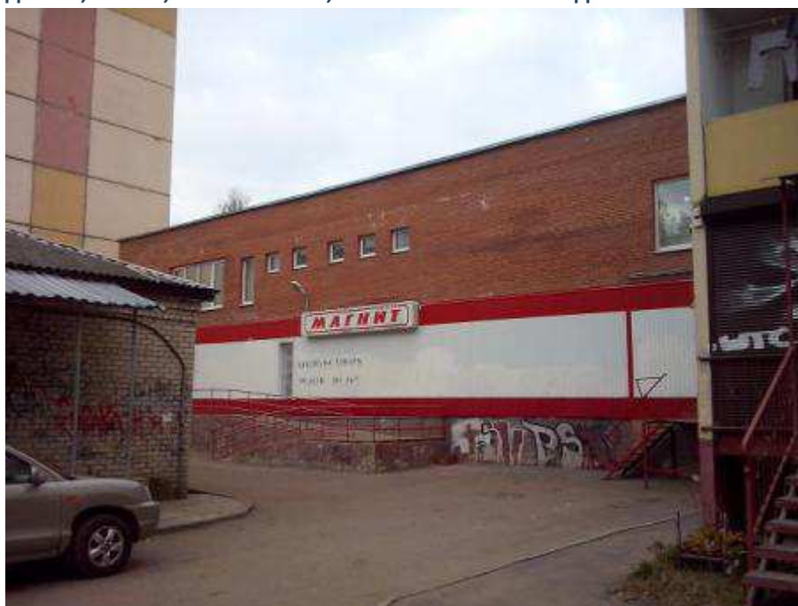
Рисунок 5. Магазин хозяйственных товаров, назначение: нежилое, 2 - этажный (подземных этажей - 1), общая площадь 609,2 кв.м., инв. №15765, лит. А1 – внешний вид
