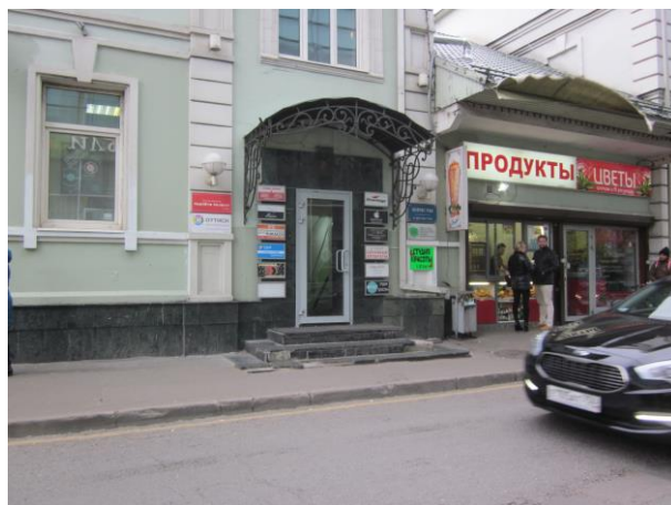
Вход в здание и оцениваемое помещение
