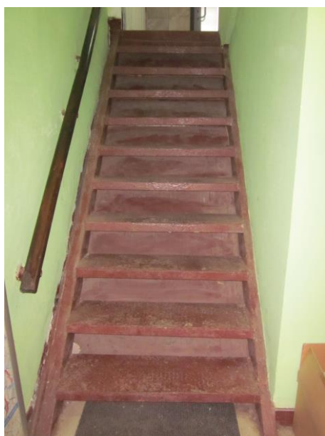
Лестница в подвальное помещение
