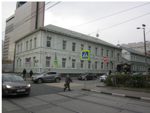
Общий вид здания (вид с Холодильного пер.)
