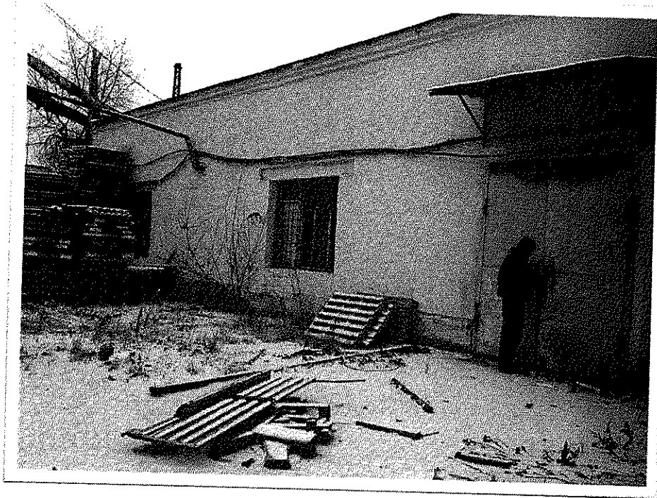
Часть нежилого здания-цех сбивки ящиков
