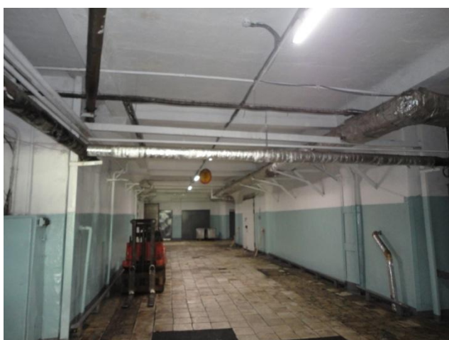
Фото 3. Состояние внутренних помещений
