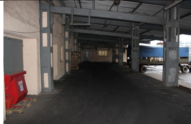
Фото 10. Состояние внутренних помещений
