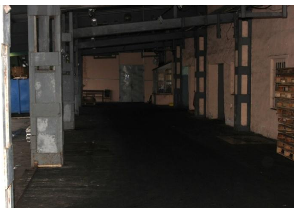
Фото 5. Состояние внутренних помещений
