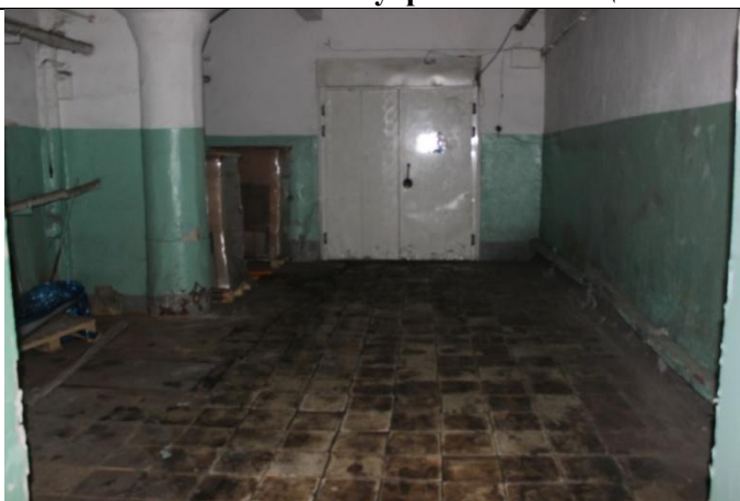
Фото 6. Состояние внутренних помещений
