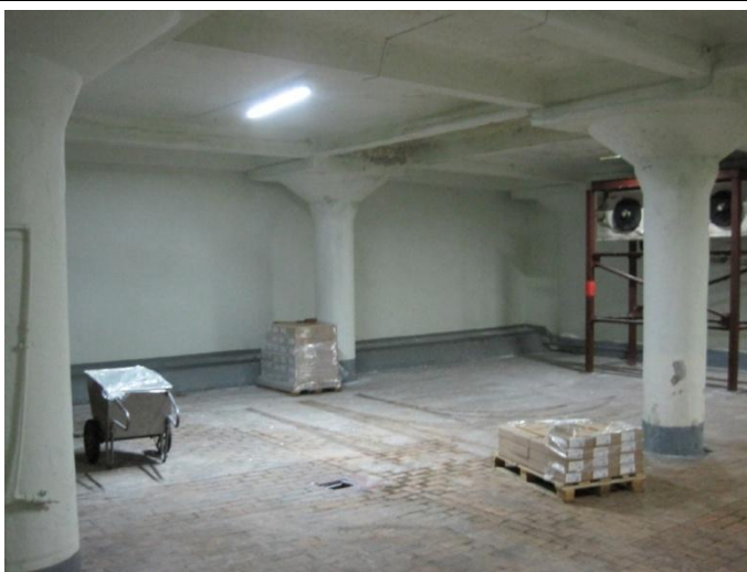
Фото 4. Состояние внутренних помещений
