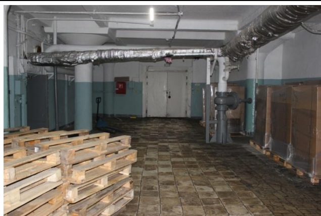
Фото 9. Состояние внутренних помещений
