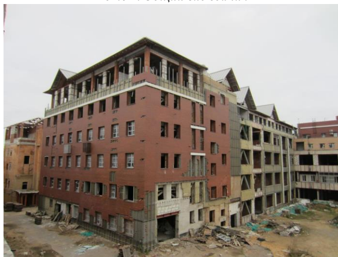
Фото 2. Общий вид здания
