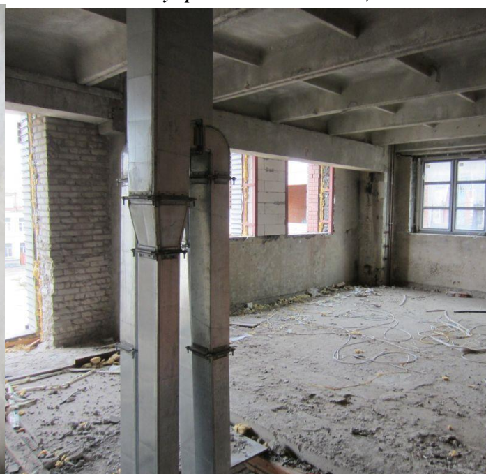
Фото 8. Внутренняя отделка помещений
