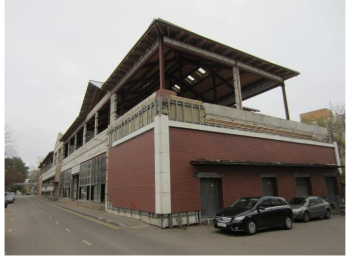
Фото 2. Общий вид здания
