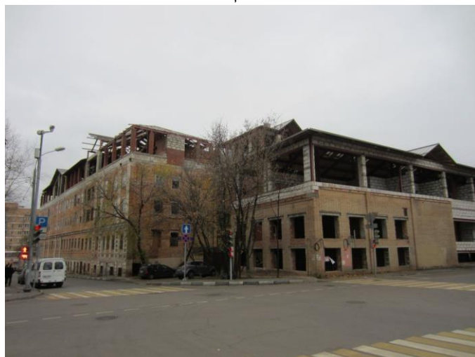
Фото 2. Общий вид здания
