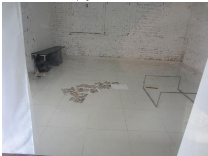
Фото 3. Внутренняя отделка помещений
