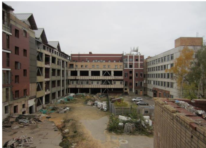
Фото 4. Общий вид здания с прилегающей территорией
