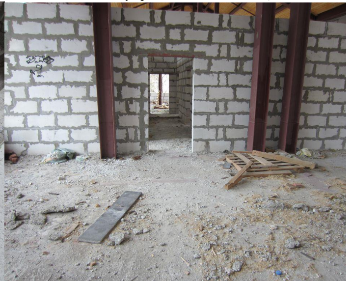
Фото 6. Внутренняя отделка помещений
