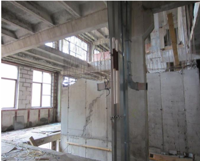
Фото 9. Внутренняя отделка помещений
