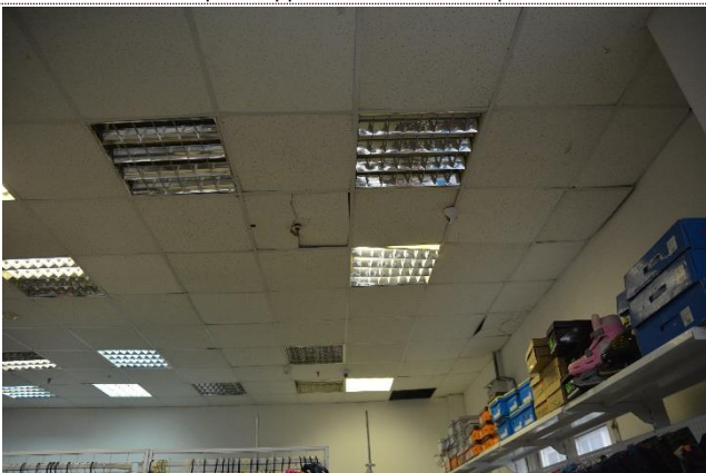
Общий вид нежилых помещений
