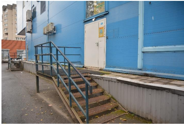
Общий вид выхода во двор
