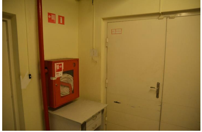
Общий вид нежилых помещений
