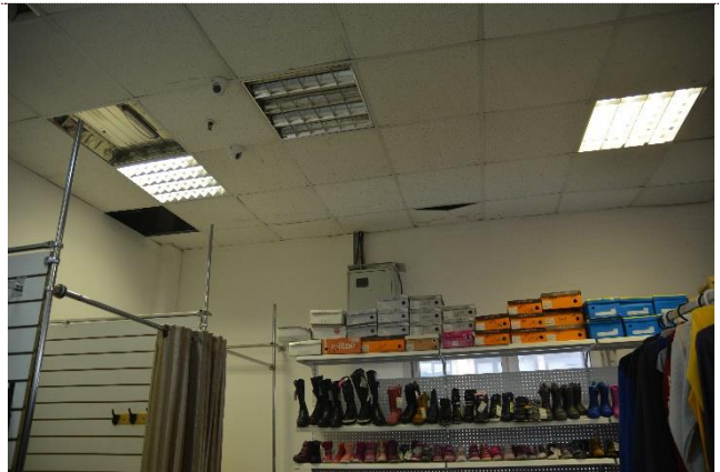
Общий вид нежилых помещений
