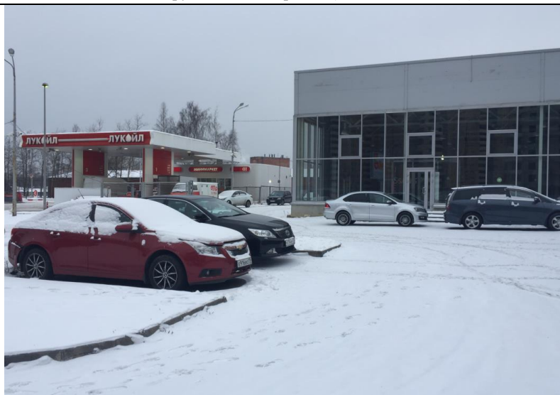
Фото 6. Окружающая застройка (здание автозаправочной станции).
