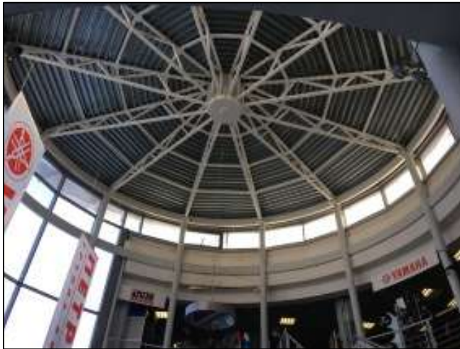
Фото 15 Типичное состояние внутренних помещений
