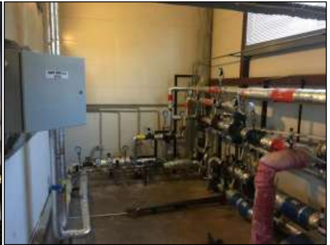
Фото 16 Типичное состояние внутренних помещений
