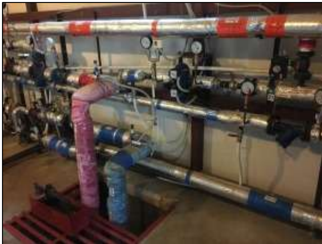
Фото 17 Типичное состояние внутренних помещений
