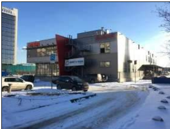
Фото 7 Общий вид здания
