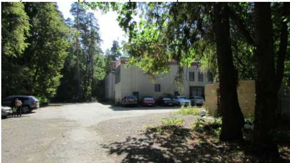
Рисунок 6.36 Сооружение: дорожки и асфальтобетонные площадки
