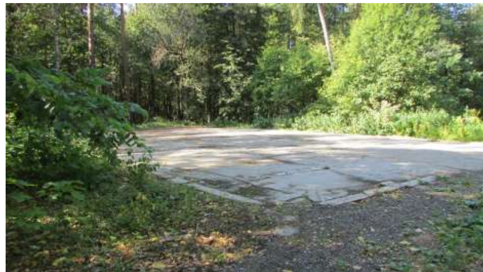
Рисунок 6.35 Сооружение: дорожки и асфальтобетонные площадки
