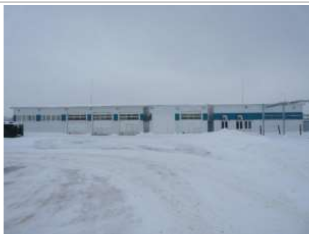
Фото 105. Инв. № 00001866, здание для хранения пожарной техники
