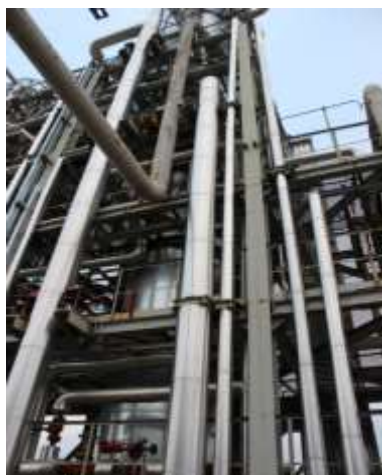
Фото 122. Инв. № 00001446 , колонна К2
