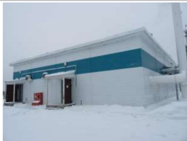
Фото 2. Инв. № 00001521, здание операторной установки ЭЛОУ-АТ-500
