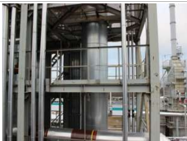
Фото 134. Инв. № 00001445, колонна К1
