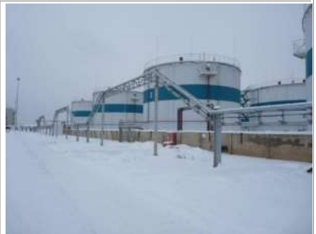
Фото 36. Инв. № 00001707, эстакады трубопроводов технологических РП№1
