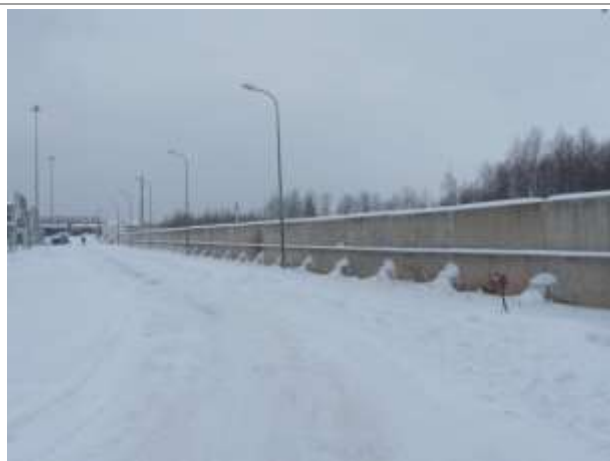
Фото 85. Планируется к вводу в эксплуатацию в декабре 2012, Периметральное ограждение
