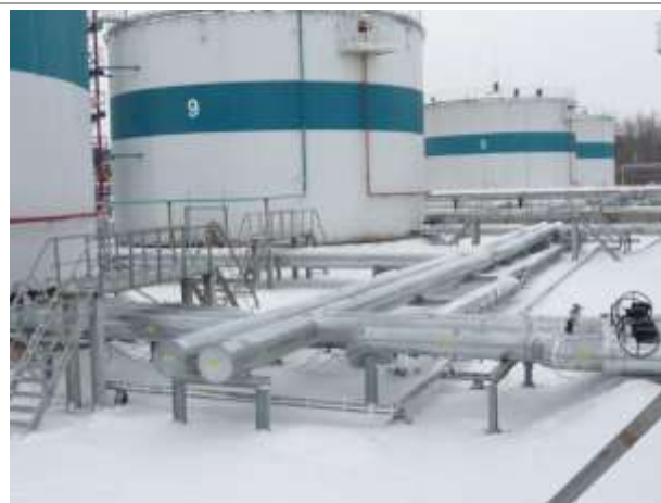
Фото 44. Инв. № 00001716, площадки обслуживания и переходные мостики РПЗ
