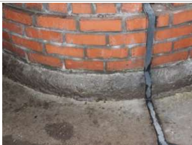
Фото 9. Инв. № 00001448, этажерка блока колонн с огнезащитным покрытием; Инв. № 00001451, фундамент блока колонн
