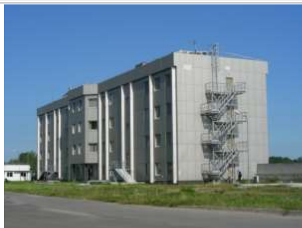
Фото 24. Здание производственно-диспетчерского комплекса (ПДК)
