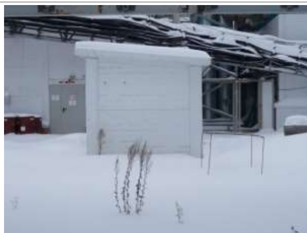
Фото 64. Инв. № 00001761, скважины забора воды на технические нужды №4 (30.2)
