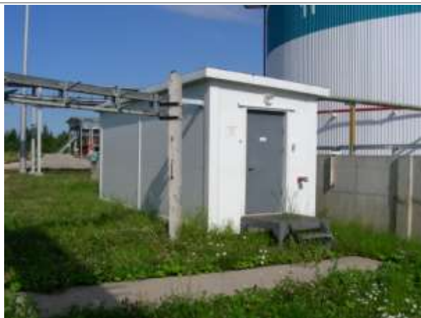
Фото 13. Здание узла управления задвижками противопожарной защиты
