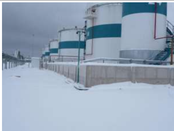
Фото 51. Инв. № 00001856, обвалование бетонное и покрытие бетонное 4
