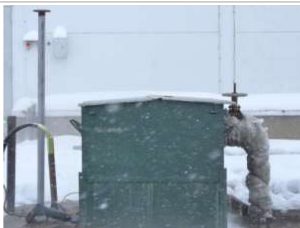
Фото 89. Инв. № 00001859, Дренажная емкость для соледержащих стоков (емкость 10м3 с ЖБ фундаментом)
