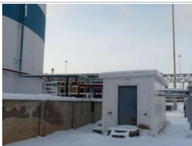
Фото 103. Инв. № 00001931, здание узла управления задвижками противопожарной защиты (31.2)
