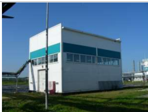
Фото 4. Здание насосной автоматической станции пожаротушения
