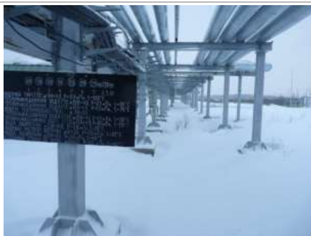
Фото 83. Инв. № 00001945, эстакады МЦК между энергоцентром, КОС и насосными
