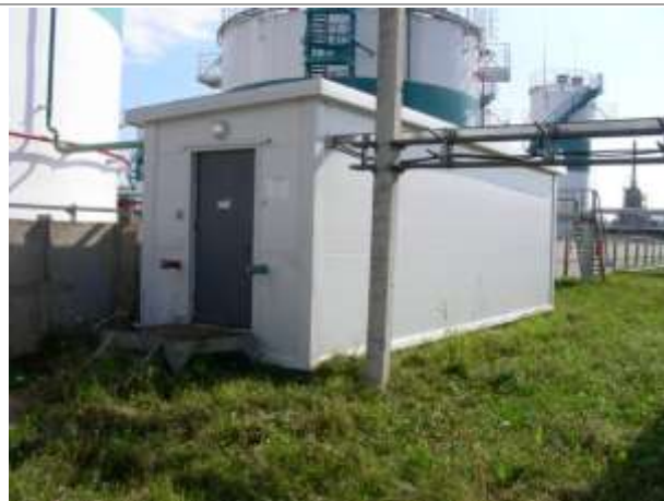
Фото 14. Здание узла управления задвижками противопожарной защиты
