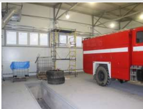
Фото 106. Инв. № 00001866, здание для хранения пожарной техники
