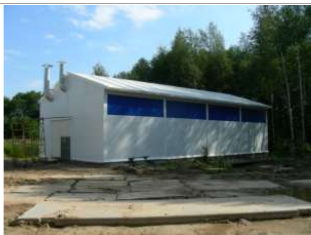
Фото 27. Станция водоподготовки (за территорией)
