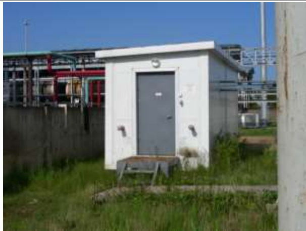
Фото 11. Здание узла управления задвижками противопожарной защиты
