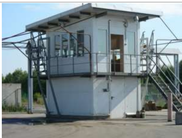
Фото 5. Здание поста охраны
