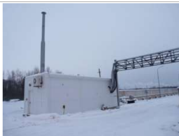
Фото 60. Инв. № 00001858, здание электрощитовой АСУр-ПБ-500
