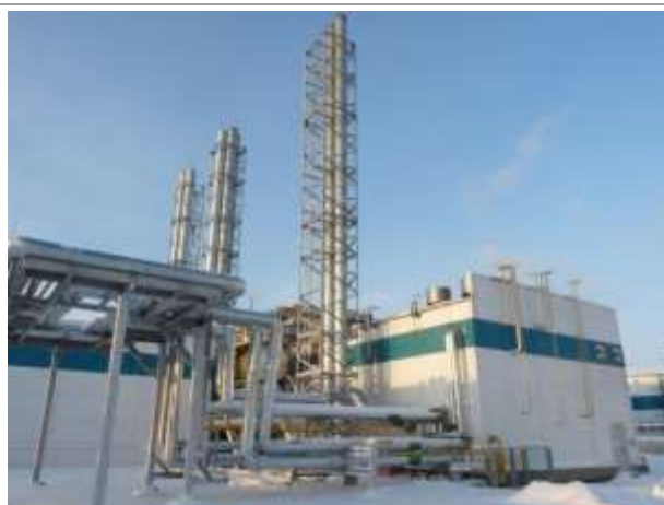
Фото 107. Здание энергоцентра с оборудованием и сетями
