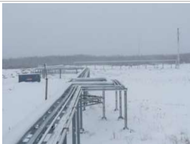
Фото 81. Инв. № 00001943, эстакады МЦК от ЭЛОУ до факельного хозяйства
