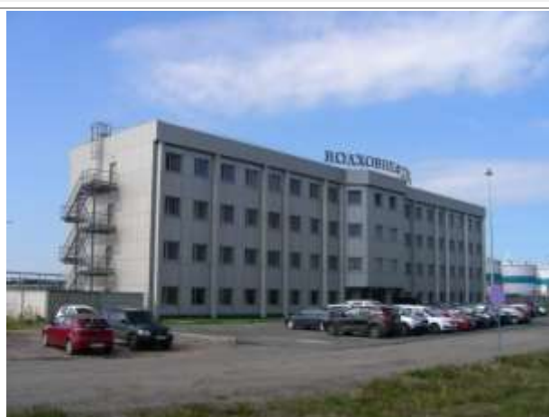
Фото 25. Здание производственно-диспетчерского комплекса (ПДК)
