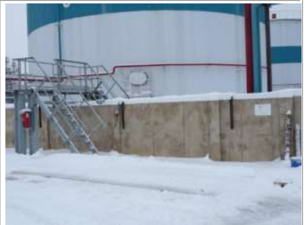
Фото 38. Инв. № 00001854, обвалование бетонное и покрытие бетонное 2
