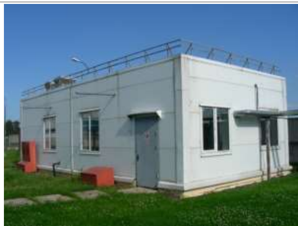
Фото 2. Здание установки испытания топлива (УИТ)
