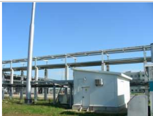
Фото 20. Здание электрошлаковой АСУР-ПБ-120
