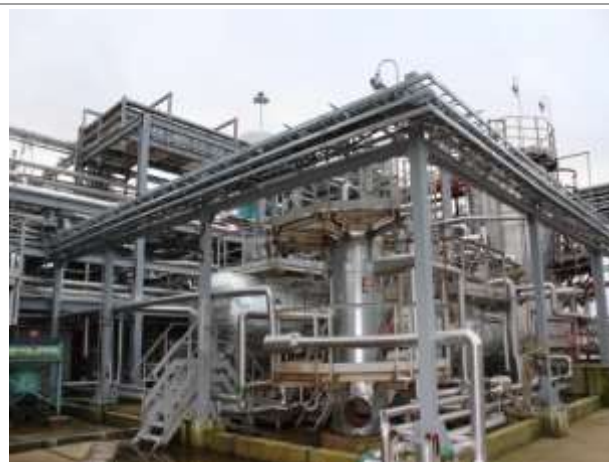
Фото 10. Инв. № 00001455, площадки обслуживания блока ЭЛОУ металлоконструкции
