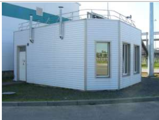
Фото 19. Здание операторной АСН
