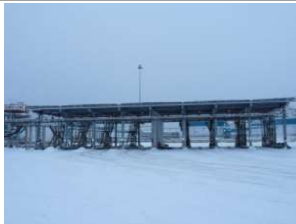
Фото 14. Автоматизированная станция налива нефтепродуктов в автоцистерны под навесом
