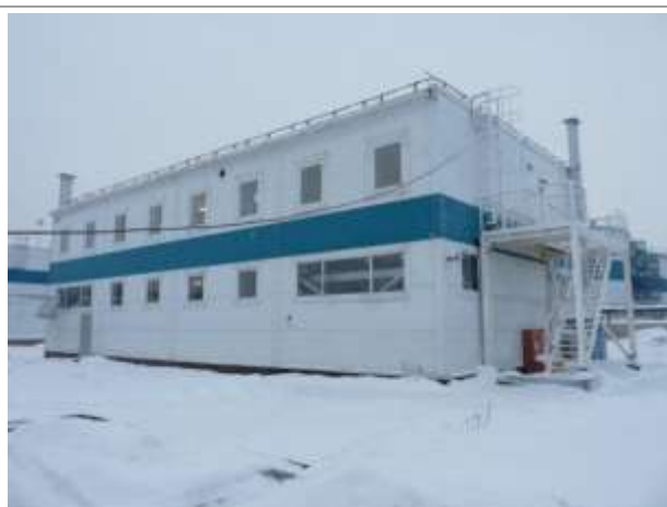
Фото 101. Планируется к вводу в эксплуатацию в декабре 2012, Ремонтно-механические мастерские (РММ)
