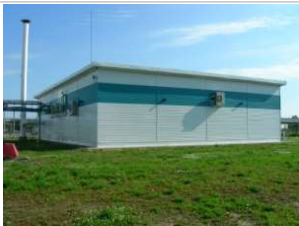
Фото 1. Здание операторной уст-ки ЭЛОУ- АТ-500
