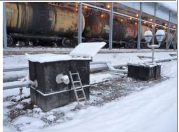
Фото 26. Инв. № 00001695, резервуар аварийного пролива №25.1 ЛВЖ
