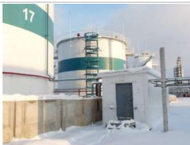
Фото 104. Инв. № 00001934, здание узла управления задвижками противопожарной защиты (31.5)
