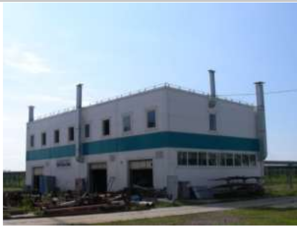
Фото 7. Здание ремонтно-механических мастерских (РММ)
