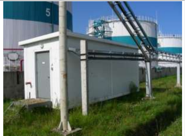
Фото 12. Здание узла управления задвижками противопожарной защиты
