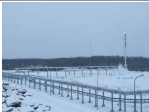
Фото 4. Открытая факельная система для утилизации аварийных выбросов с ЭЛОУ АТ-450
