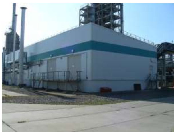
Фото 15. Здание водяной насосной
