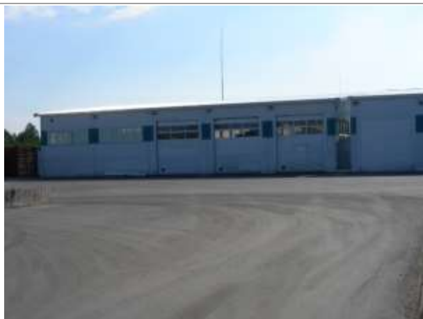
Фото 17. Здание для хранения пожарной техники
