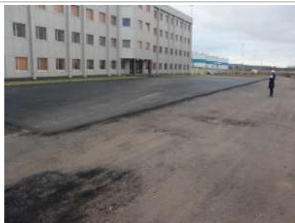
Фото 88. Планируется к вводу в эксплуатацию в декабре 2012, площадка стоянки бензовозов (49)
