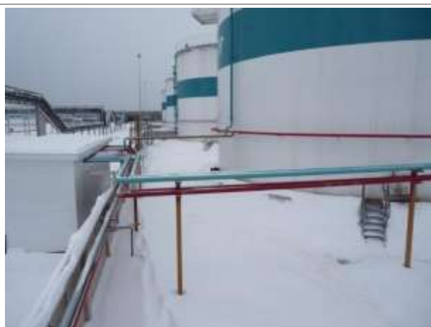
Фото 59. Инв. № 00001741, эстакады трубопроводов и сетей внутрипарковых 4
