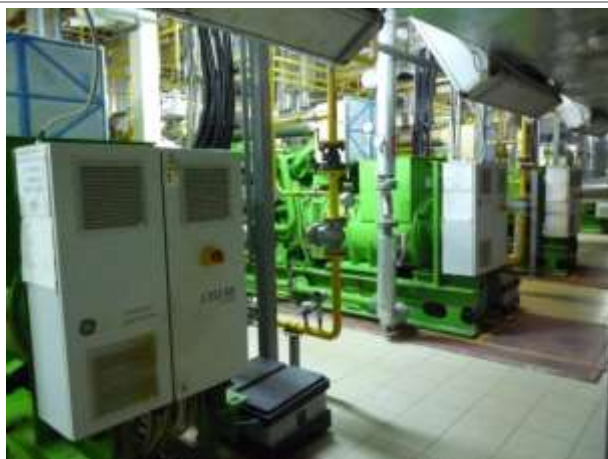
Фото 114. Инв. № 00001822, газопоршневые агрегаты JMS 312 №№1-3
