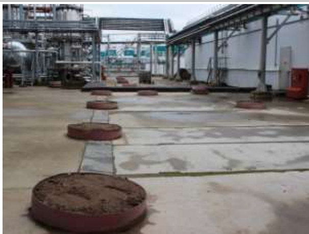
Фото 13. Инв. № 00001555, сети промышленно-ливневой канализации установки
