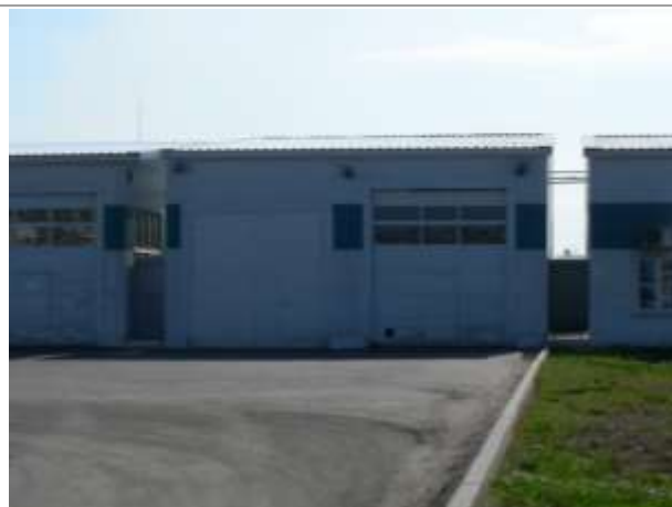
Фото 18. Здание для хранения спецтехники и специнвентаря
