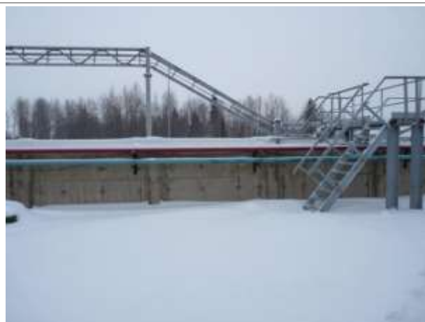
Фото 32. Инв. № 00001853, обвалование бетонное и покрытие бетонное 1
