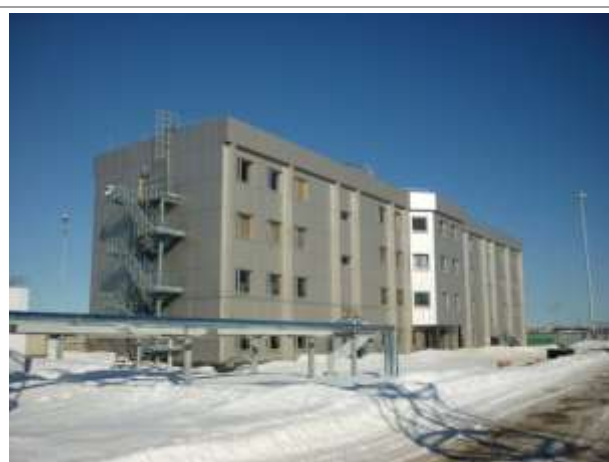
Фото 92. Планируется к вводу в эксплуатацию в декабре 2012, ПДК здание
