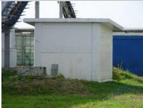
Фото 9. Здание скважин забора технической воды
