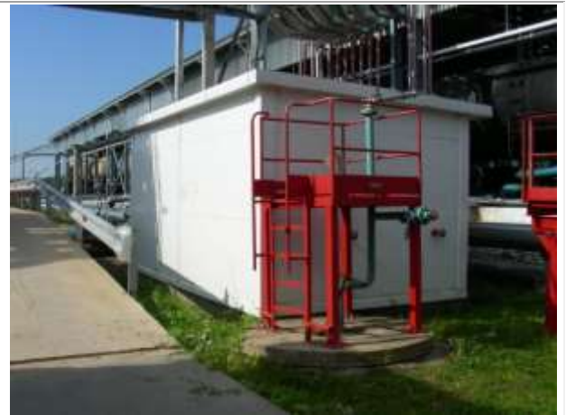
Фото 10. Здание узла управления задвижками противопожарной защиты
