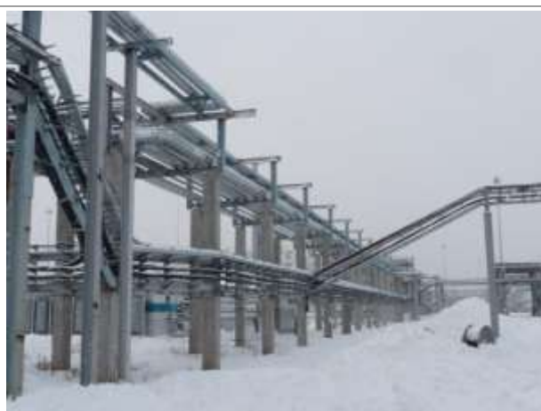
Фото 79. Инв. № 00001938, МЦК от установки ЭЛОУ до резервуарных парков
