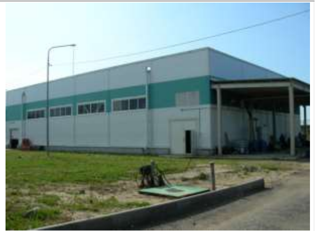
Фото 8. Здание комплекса очистных сооружений (КОС-1)
