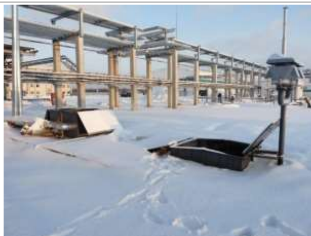
Фото 31. Инв. № 00001700, площадки обслуживания и переходные мостики РП 1
