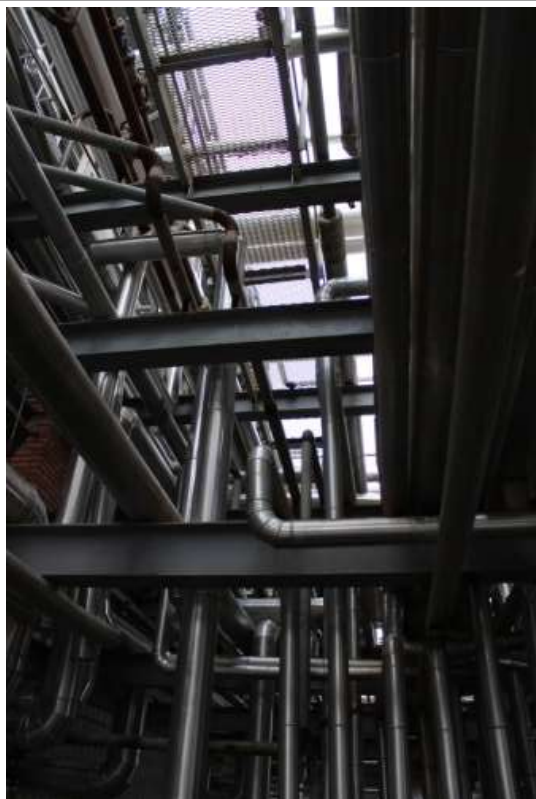
Фото 11. Инв. № 00001552, сооружение межблочной эстакады
