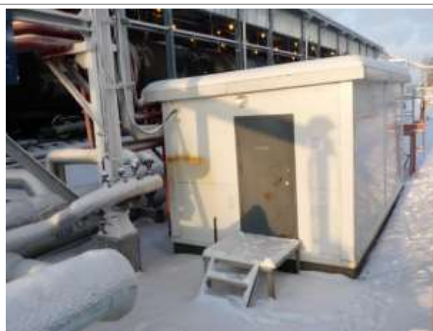
Фото 102. Инв. № 00001930, здание узла управления задвижками противопожарной защиты (31.1)
