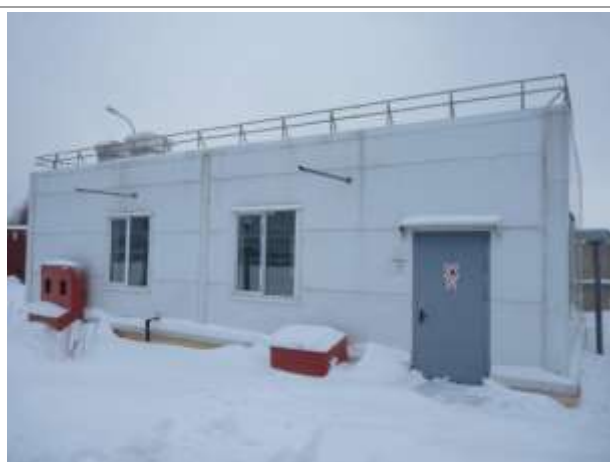
Фото 73. Планируется к вводу в эксплуатацию в декабре 2012, Здание установки испытания топлива (УИТ)
