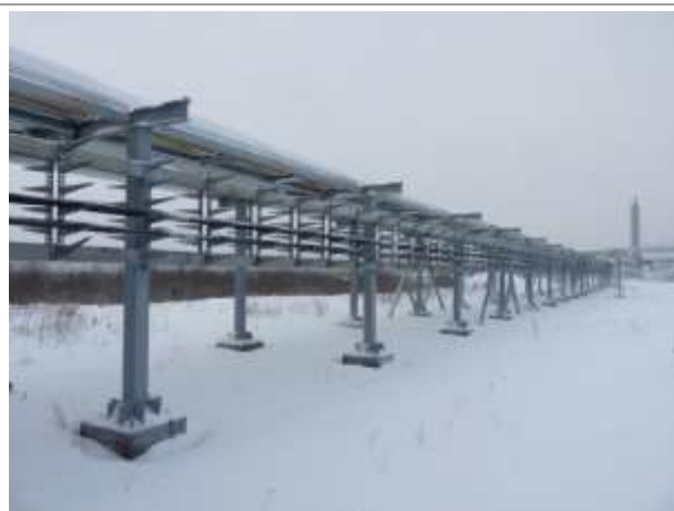
Фото 82. Инв. № 00001944, эстакады МЦК между энергоцентром и ПДК
