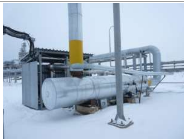
Фото 6. Инв. № 00001525, факельный сепаратор
