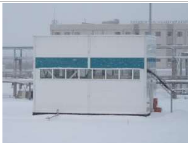
Фото 84. Инв. № 00001780, Здание насосной автоматической станции пожаротушения
