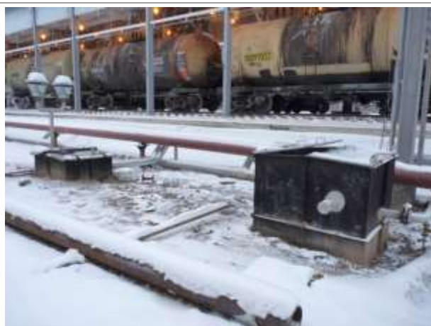
Фото 27. Инв. № 00001696, резервуар аварийного пролива №25.2 ЛВЖ
