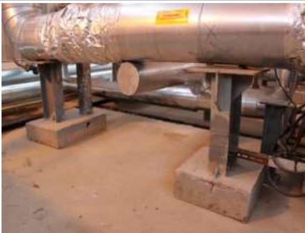
Фото 23. Инв. № 00001686, эстакады трубопроводов и сетей насосной ГЖ №2
