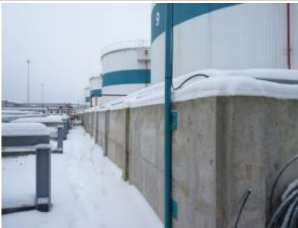
Фото 45. Инв. № 00001855, обвалование бетонное и покрытие бетонное 3
