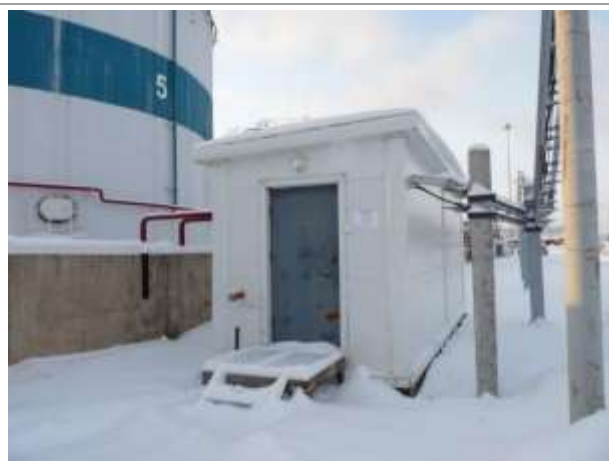
Фото 139. Инв. № 00001932, здание узла управления задвижками противопожарной защиты (31.3)
