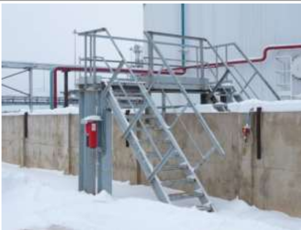
Фото 37. Инв. № 00001708, площадки обслуживания и переходные мостики РП2
