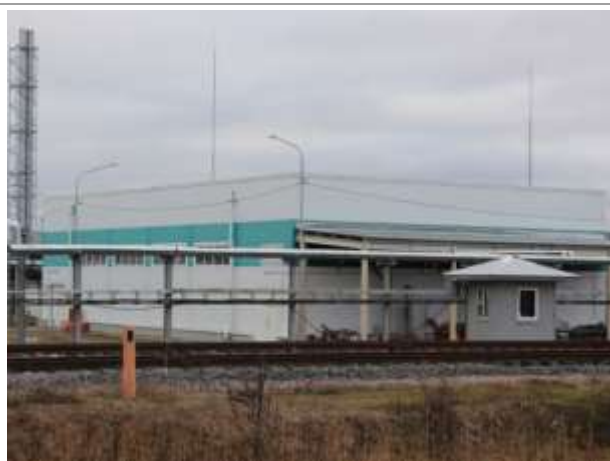
Фото 67. Комплекс очистных сооружений (КОС)
