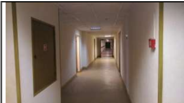
Фото 11 Часть здания, внутри
