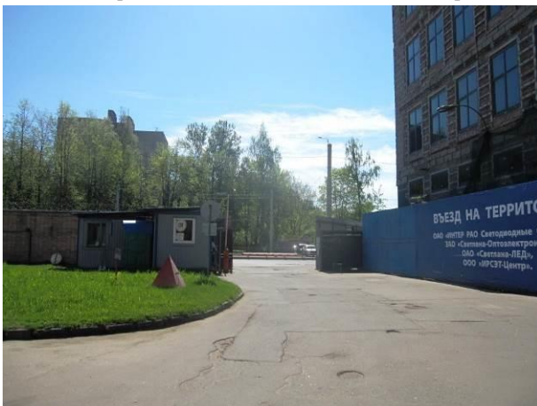
Подъезд к пром.площадке о со Светлановского проспекта
