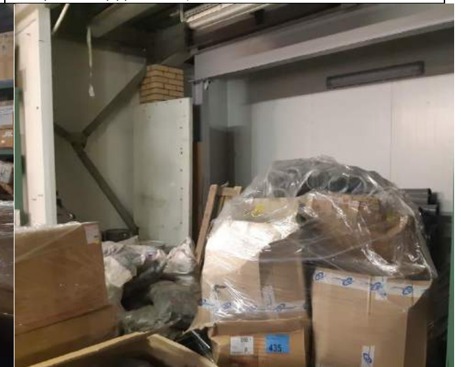
Московская область, город Балашиха, микрорайон Керамик, улица Керамическая, д.2, строение 4, Литер Б, общей площадью 2316,1 кв. м
