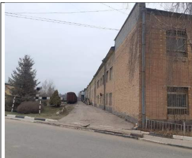
Московская область, город Балашиха, микрорайон Керамик, улица Керамическая, д.3, Литера Б,Б1, общей площадью 2364,2 кв. м
