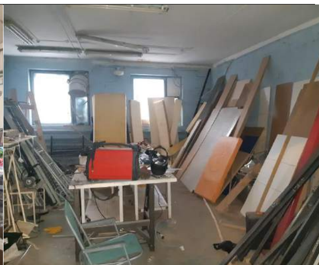
Московская область, город Балашиха, микрорайон Керамик, улица Керамическая, д.3, Литера Б,Б1, общей площадью 2364,2 кв. м
