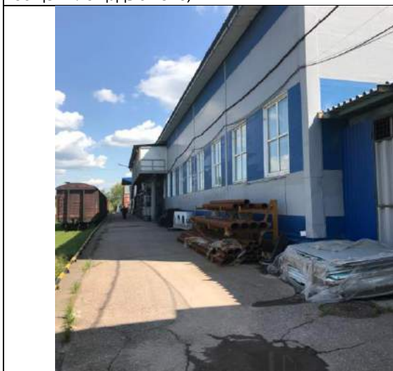
Московская область, город Балашиха, микрорайон Керамик, улица Керамическая, д.2, строение 4, Литер Б, общей площадью 2316,1 кв. м
