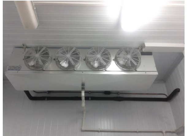
Установка Холодильной камеры ХК-1
