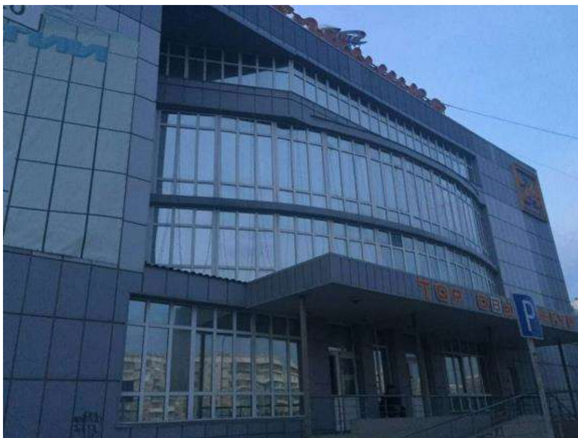
Рисунок 1 Магазин (здание), назначение: нежилое, 4-этажный (подземных этажей - 1), общая площадь 3665, 1 кв.м, инв.№328/1, лит.Б, адрес объекта: Кемеровская область, г.Новокузнецк, Новоильинский район, проспект Авиаторов, д.55, корп.1
