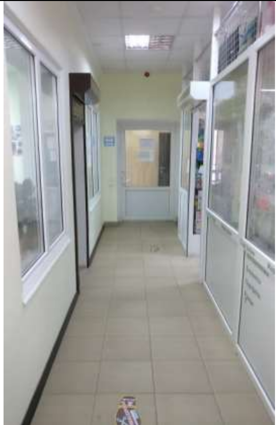
ФОТО № 40. Состояние внутренней отделки Объекта оценки.
