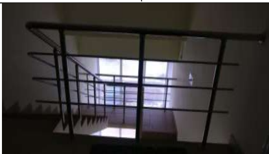
ФОТО № 25. Состояние внутренней отделки Объекта оценки.
