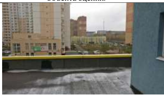
ФОТО № 34. Состояние внутренней отделки Объекта оценки.
