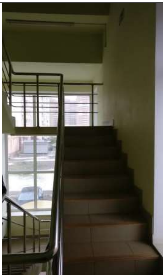
ФОТО № 16. Состояние внутренней отделки Объекта оценки.
