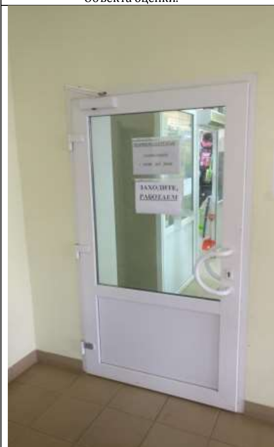
ФОТО № 21. Состояние внутренней отделки Объекта оценки.
