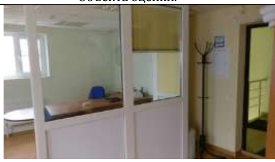
ФОТО № 36. Состояние внутренней отделки Объекта оценки.
