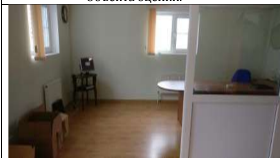
ФОТО № 35. Состояние внутренней отделки Объекта оценки.
