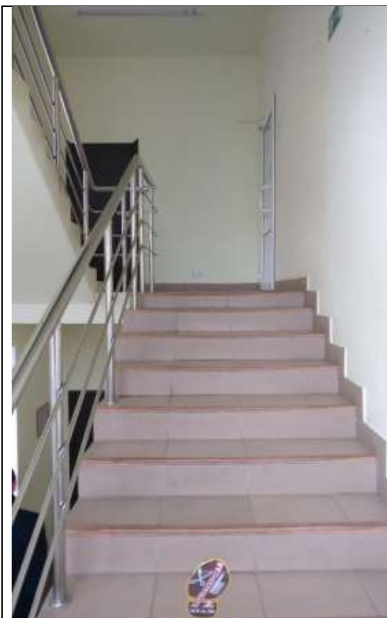
ФОТО № 15. Состояние внутренней отделки Объекта оценки.
