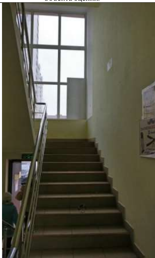
ФОТО № 14. Состояние внутренней отделки Объекта оценки.
