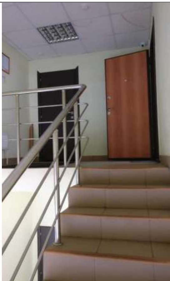
ФОТО № 24. Состояние внутренней отделки Объекта оценки.
