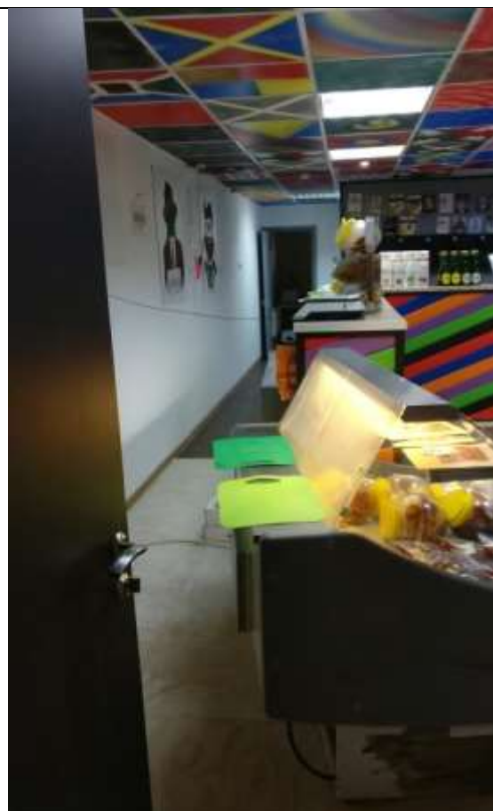
ФОТО № 50. Состояние внутренней отделки Объекта оценки.
