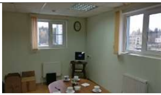
ФОТО № 30. Состояние внутренней отделки Объекта оценки.
