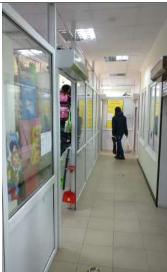
ФОТО № 20. Состояние внутренней отделки Объекта оценки.
