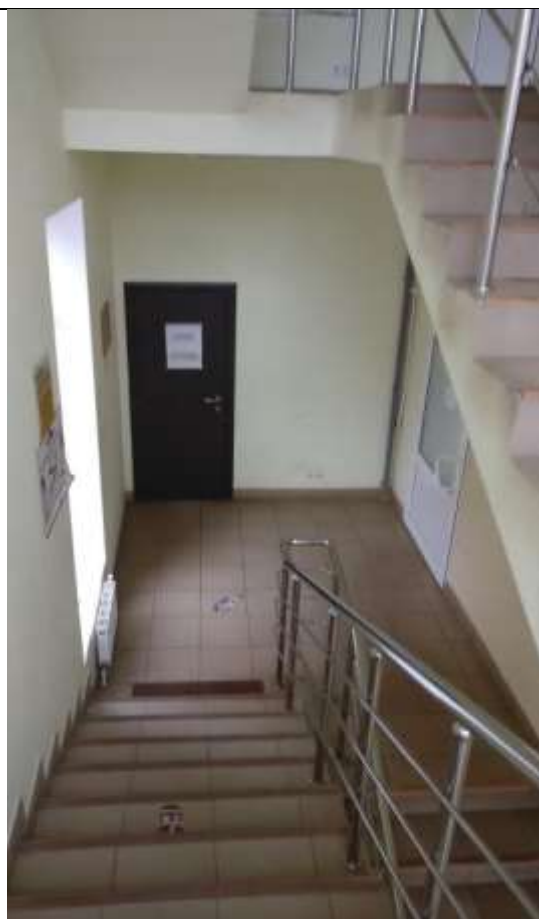
ФОТО № 42. Состояние внутренней отделки Объекта оценки.
