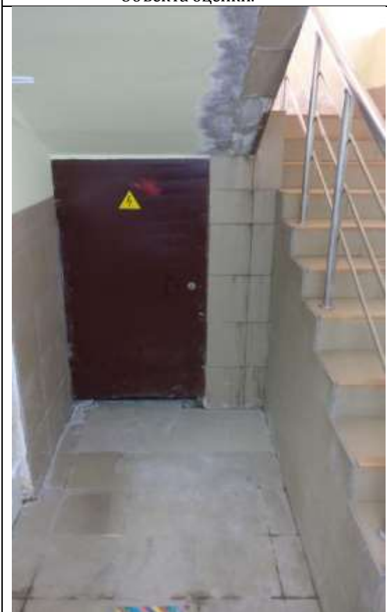
ФОТО № 47. Состояние внутренней отделки Объекта оценки.
