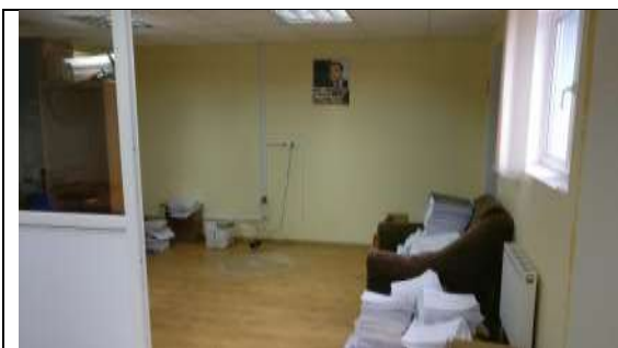
ФОТО № 29. Состояние внутренней отделки Объекта оценки.
