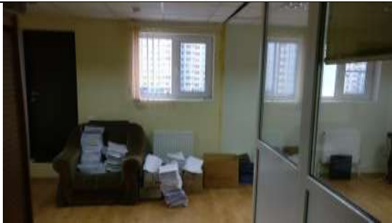
ФОТО № 27. Состояние внутренней отделки Объекта оценки.
