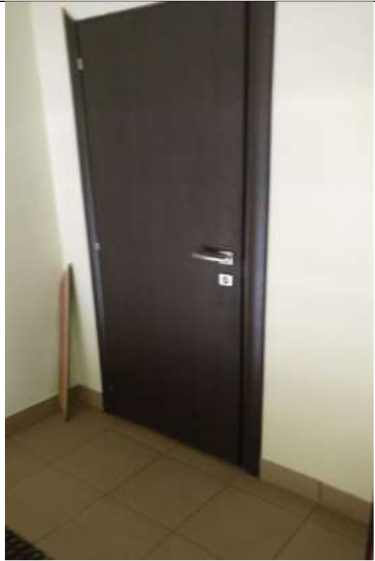
ФОТО № 38. Состояние внутренней отделки Объекта оценки.
