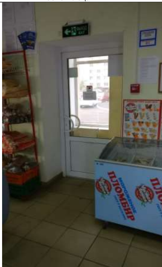
ФОТО № 44. Состояние внутренней отделки Объекта оценки.
