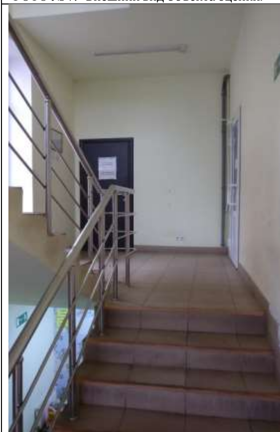
ФОТО № 9. Состояние внутренней отделки Объекта оценки.
