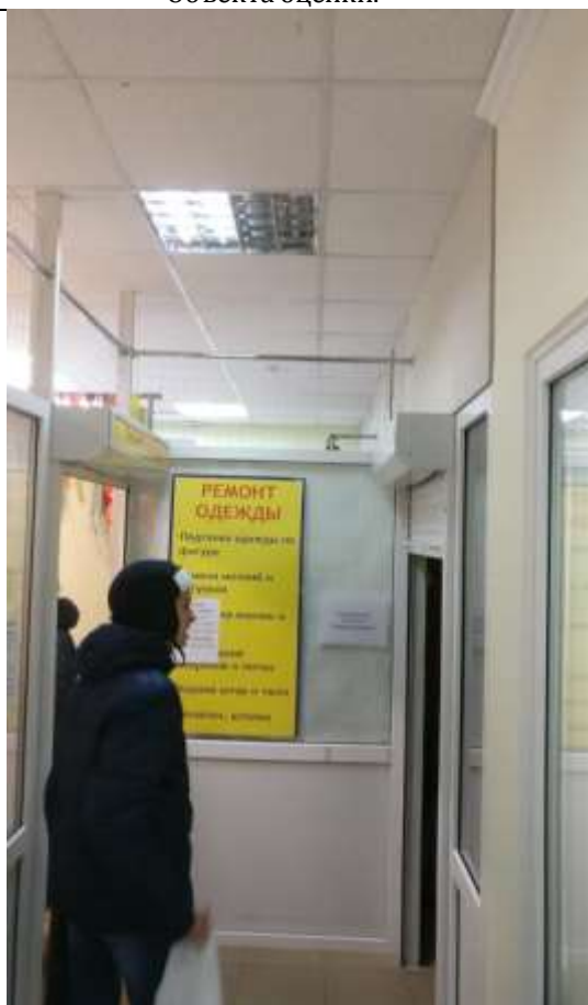
ФОТО № 18. Состояние внутренней отделки Объекта оценки.
