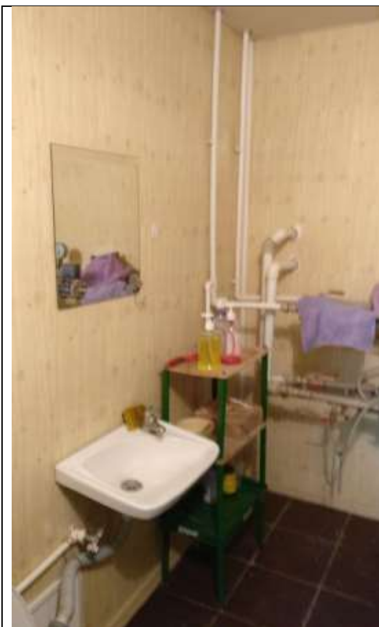
ФОТО № 49. Состояние внутренней отделки Объекта оценки.
