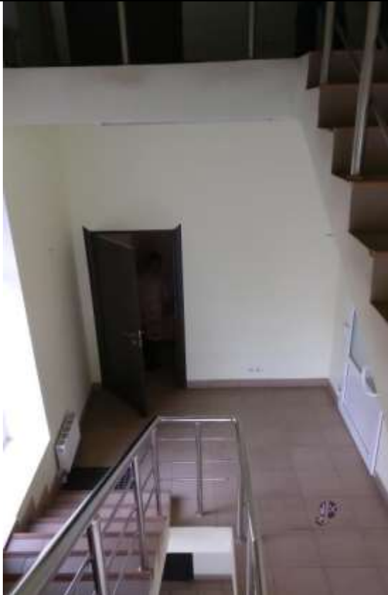
ФОТО № 39. Состояние внутренней отделки Объекта оценки.
