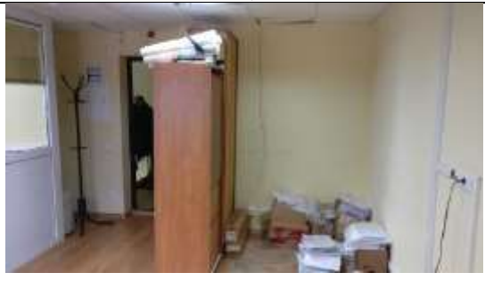
ФОТО № 28. Состояние внутренней отделки Объекта оценки.
