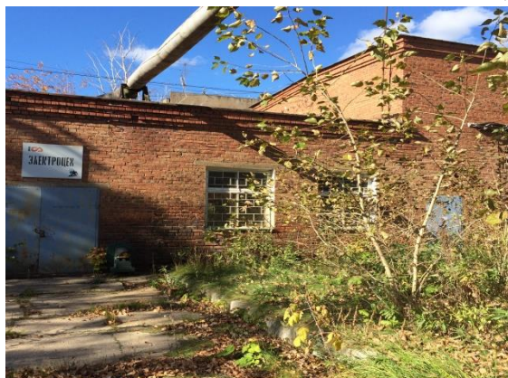
Здание Цех № 2 (электроцех)
